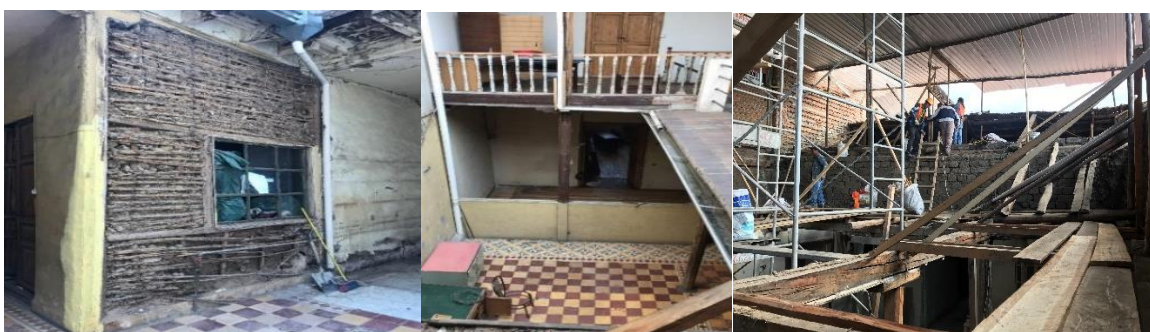
Figura 34: Registro fotográfico antes de la intervención de la casa.
