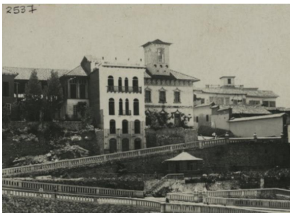
Figura 51: Balcones originales de la fachada sur.
