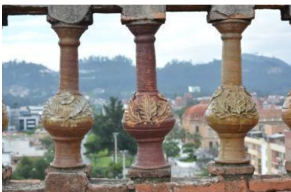
Figura 63: Balaustrada de cerámica
