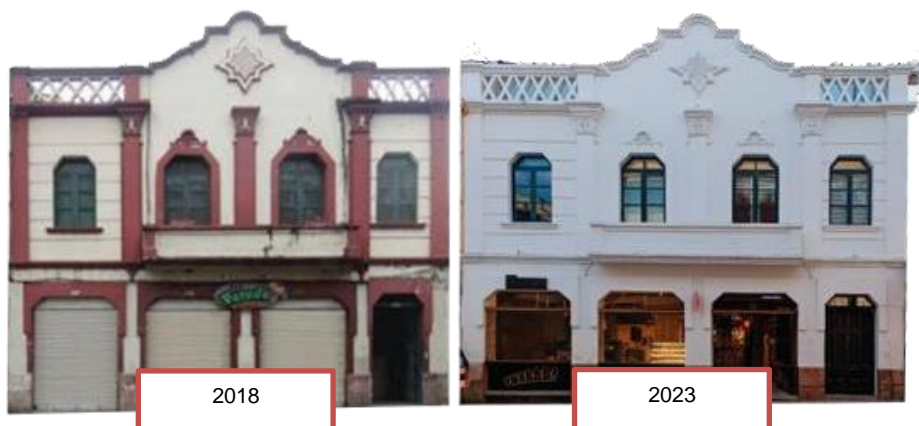
Figura 55: Comparativa fachada norte.
