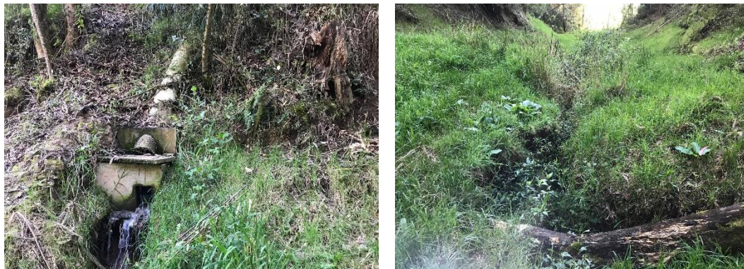
Ilustración 14 Descarga final del efluente de la PTAR ubicada en el sector de Quillopungo.
