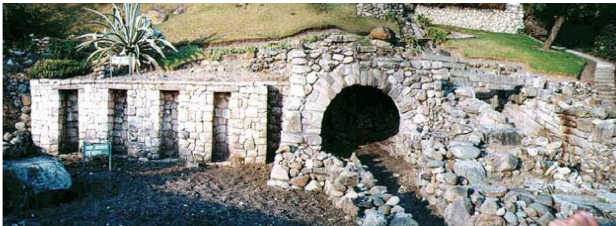
FIGURA 1.14: Técnica de labrado de la piedra. Fuente y elaboración: Junta de Andalucía (2007) . http://www.juntadeandalucia.es/fomentoyvivienda/estaticas/sites/consejeria/areas/arquitectura/fomento/guias_arquitectura/adjuntos_ga/Cuenca_e.pdf
