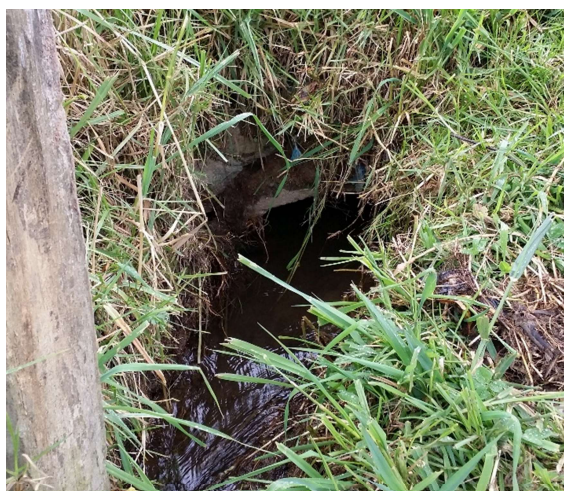
Figura 23. Tubo de hormigón usado para el cruce de agua. Fuente: Elaboración propia.
