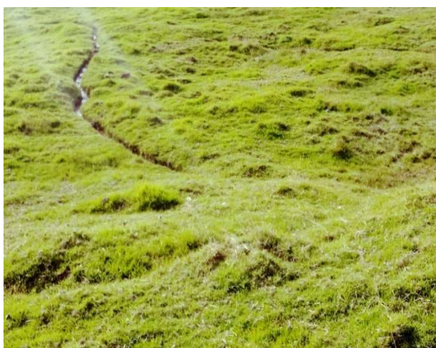
Figura 3. Afloramiento de agua en la abscisa 5+141. Fuente: Elaboración propia.
