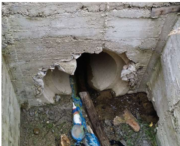
Figura 21. Alcantarilla en funcionamiento. Fuente: Elaboración propia.
