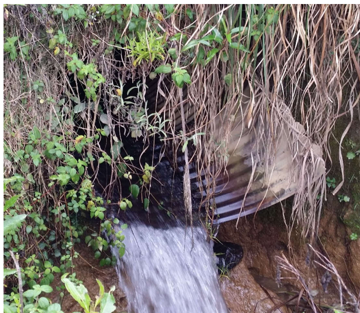
Figura 25. Alcantarilla de quebrada.
