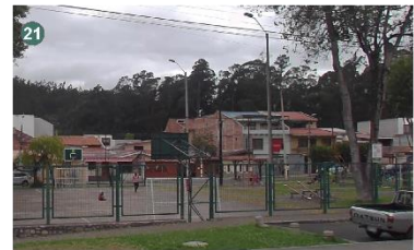
21 Equipamiento deportivo (Cancha de basket/Indor) en mal estado por falta de mantenimiento.
