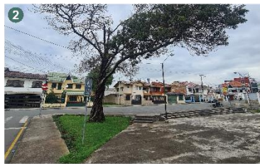
2 Losa de hormigón en mal estado con trizaduras.
