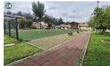
24 Camineras sin mantenimientos y sin un tratamiento especial para disminuir los
