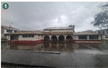
1 Casa comunal con presencia de vandalismo.
