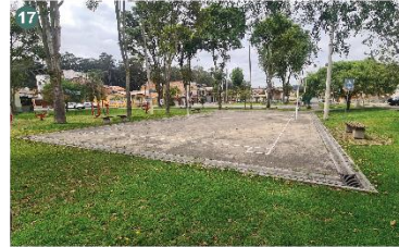
17 Equipamiento deportivo (Cancha de ecuavoley) falta de mantenimientos, muestra de
