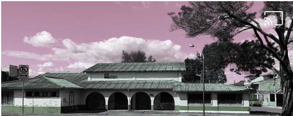
Figura 70: Imagen de la casa comunal estado actual.
