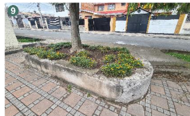
9 Espacio destinado para vegetación en mal estado.
