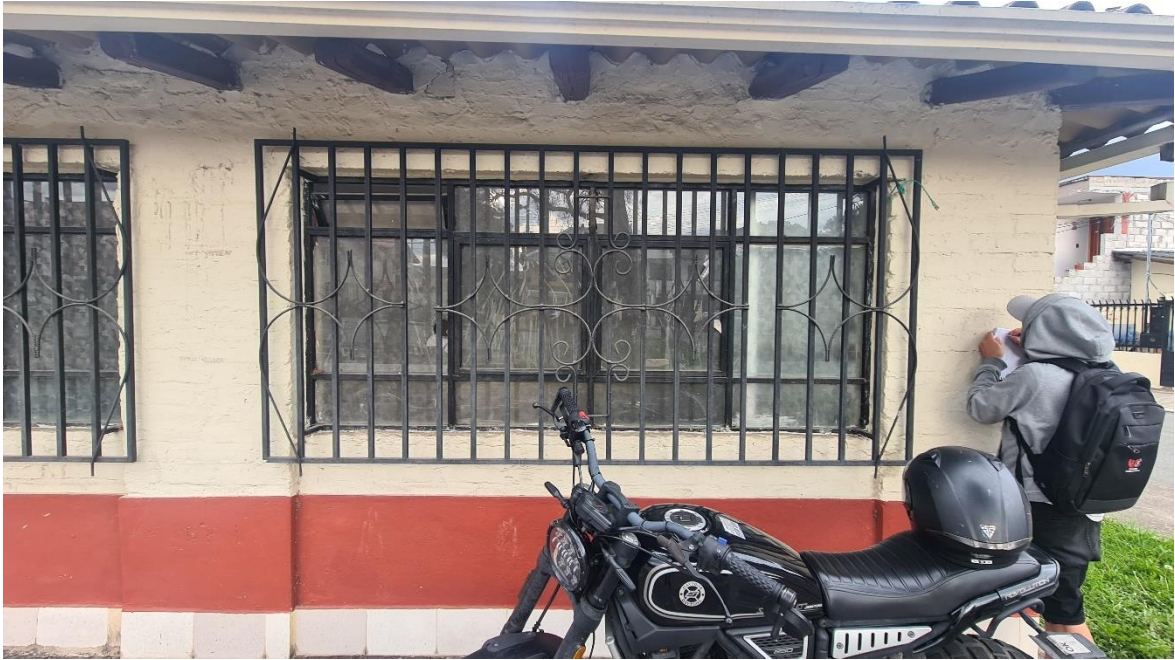
Anexo 10: Visita de campo.
