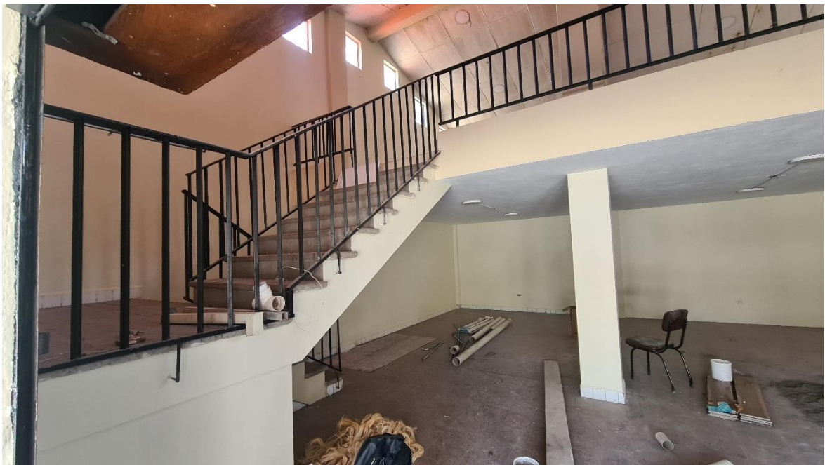
Anexo 11: Estado actual del interior de la casa comunal.
