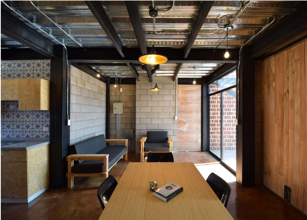
Figura 32: Uso de la estructura vista en el interior de la vivienda
