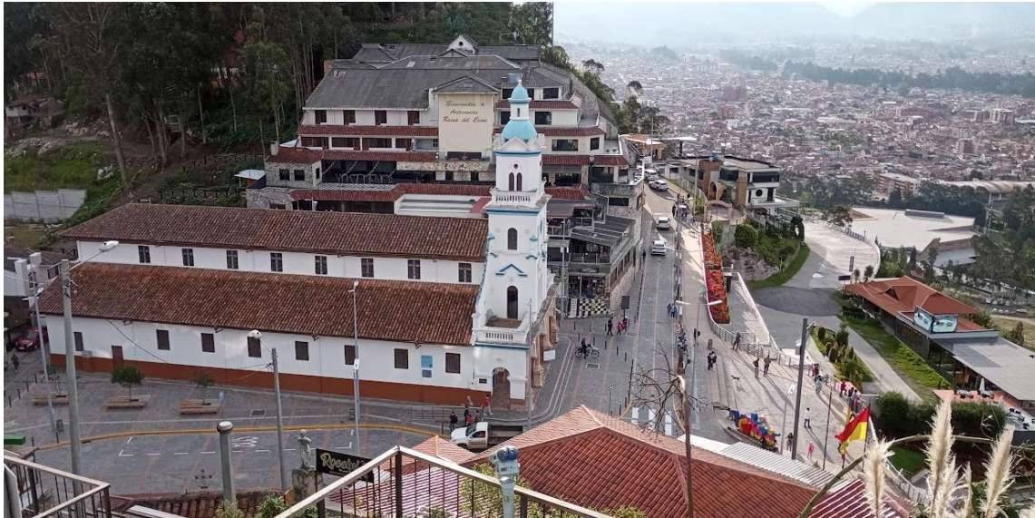
Foto 5. Turi Centro Fuente. Diego Pañi
