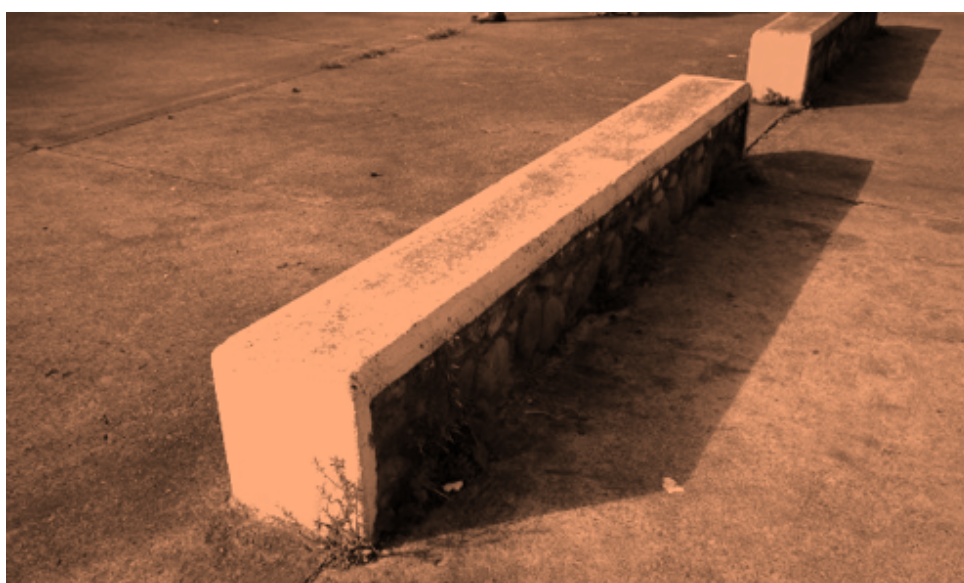
FIGURA 2.27: Problemática, Mobiliario antiestético Fuente: Fotografía benarm.
