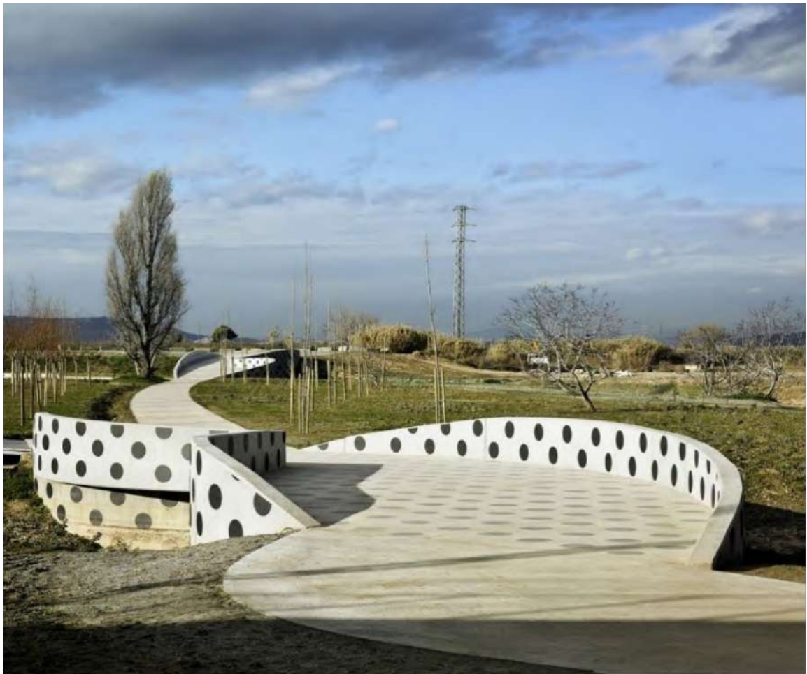
FIGURA 18: Baix Llobregat, senderos y mobiliario urbano. Fuente y elaboración: Jordi Puig, 2008 https://www.plataformaarquitectura.cl/cl/02-366576/recuperacion-ambiental-del-rio-llobregat-battle-i-roig-arquitectes
