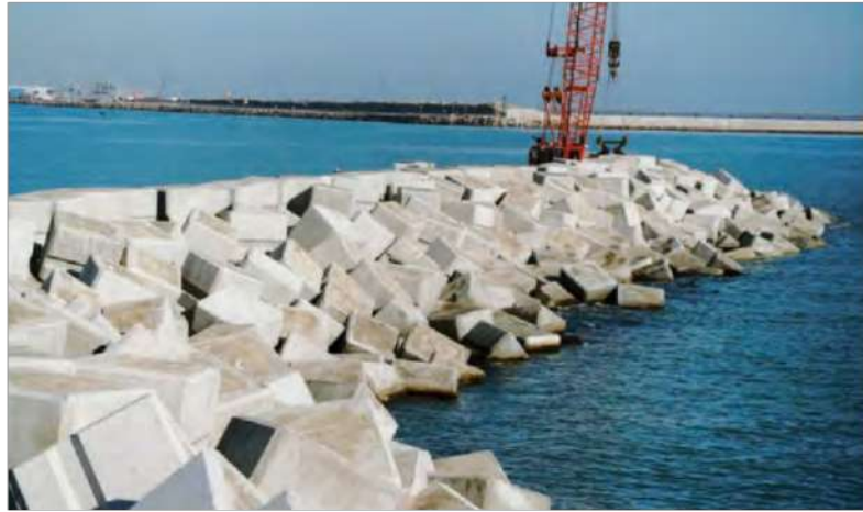
FIGURA 32: Muro rompeolas de escollera artificial. Fuente y elaboración: Gobierno de España, 2008.
