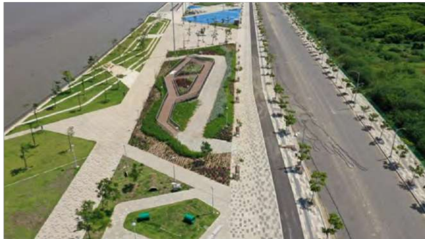
FIGURA 27: Gran Malecón, vista aérea. Fuente y elaboración: Mota-Engil, 2019. https://zonacero.com/generales/mota-engil-le-cumple-barranquilla-139226
