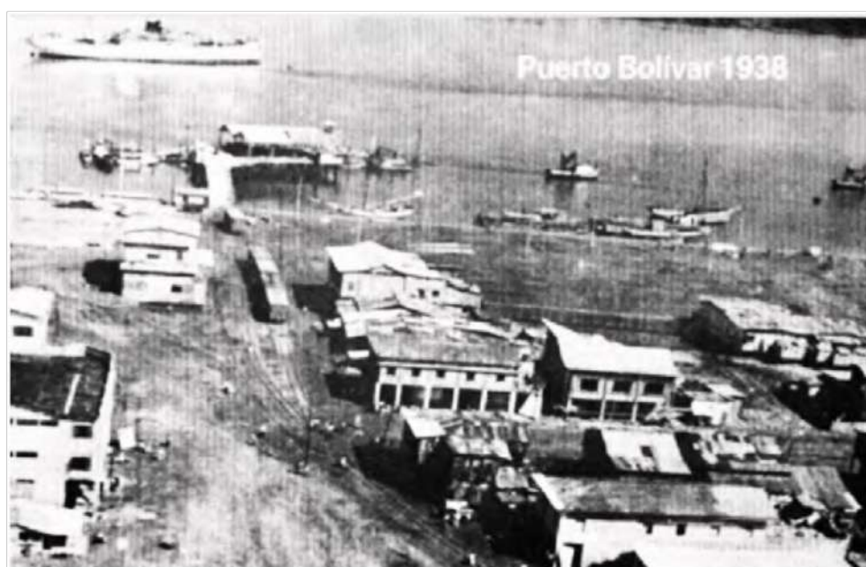
FIGURA 38: Panorámica de Puerto Bolívar. Fuente: Archivo histórico de APPB.
