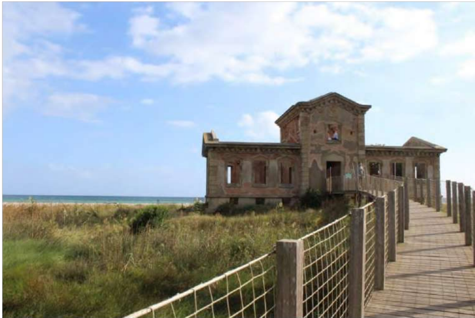
FIGURA 13: Pasarela sobreelevada y recuperación de edificación. Fuente y elaboración: Dalprá, 2020. https://www.escapadarural.com/blog/delta-del-llobregat-en-barcelona/
