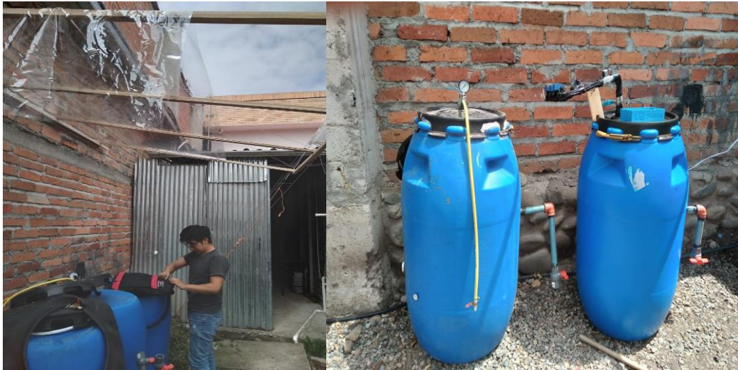
Figura 18. Colocacion de techo y nivelacion del terreno. Fuente: Elaboracion propia.
