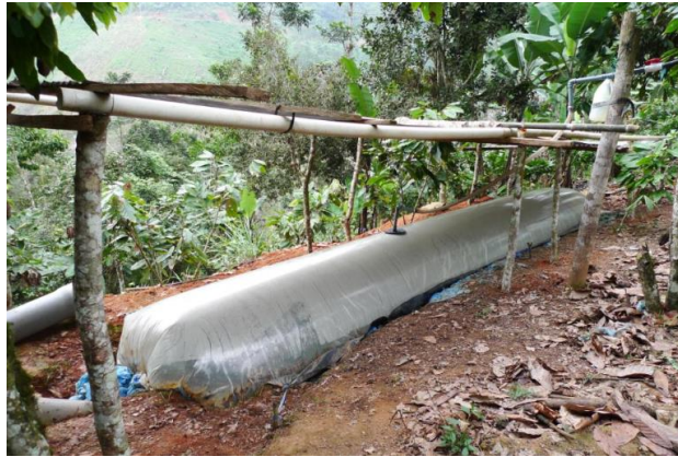
Figura 7. Biodigestor tipo Globo.
