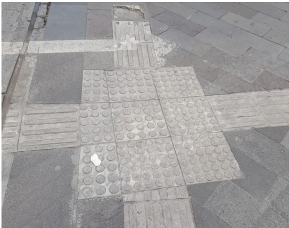
Aplicación de material podotáctil
