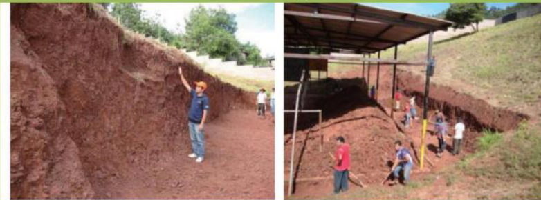
IMAGEN 7: La excavación para el muro de contención.
