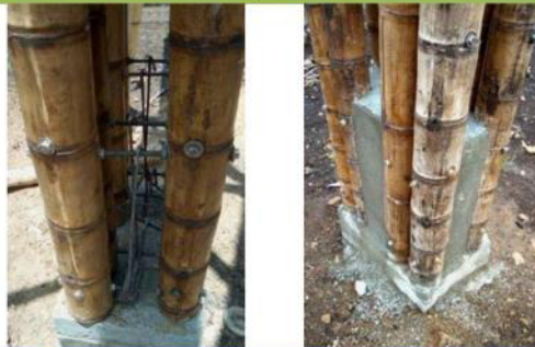
IMAGEN 33: Columna empotrada con cuatro o más postes
