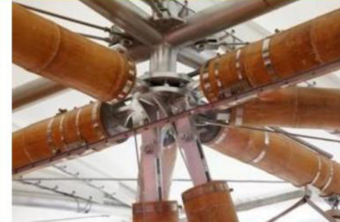
IMAGEN 34: Unión de columna articulada
