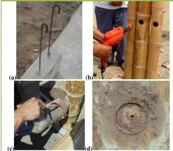
IMAGEN 35: Relleno del Mortero en la Columna
