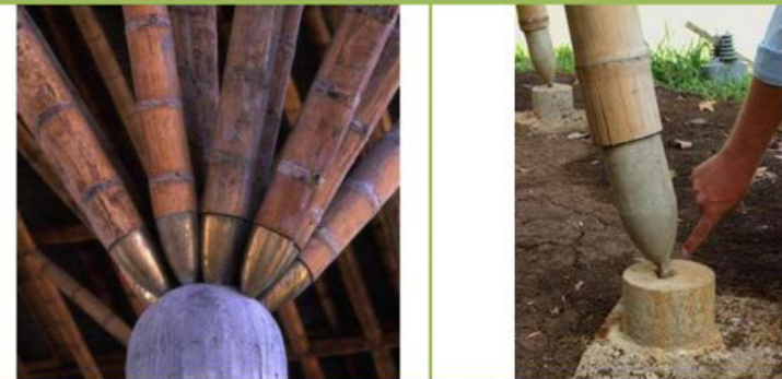
IMAGEN 36: Unión de columnas de hormigón con diagonales de guadua.
