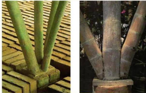
IMAGEN 17: Apoyos en ladrillos
