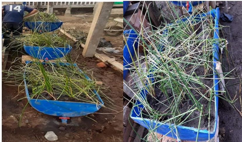
Figura 29. Colocación de grava y arena y 72 plantas Eleocharis sp. (Junco)
