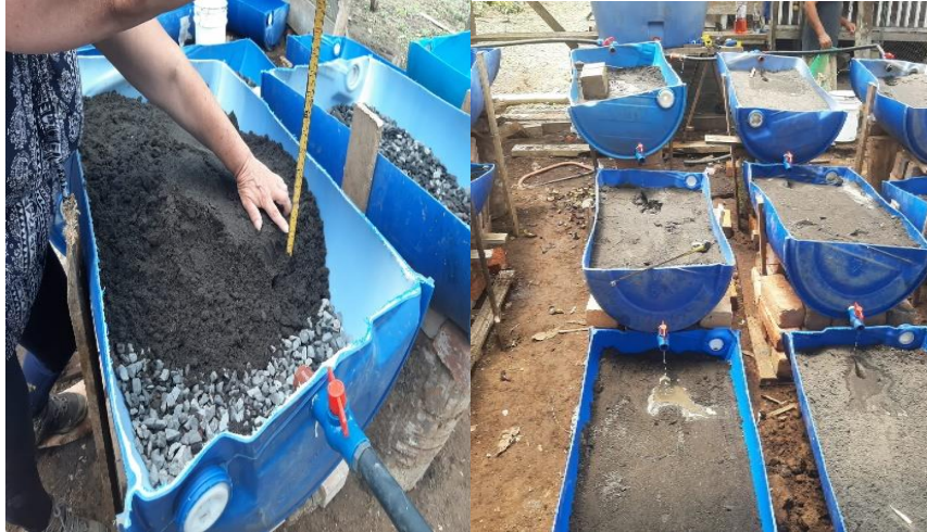
Figura 26. Colocación de grava y arena
