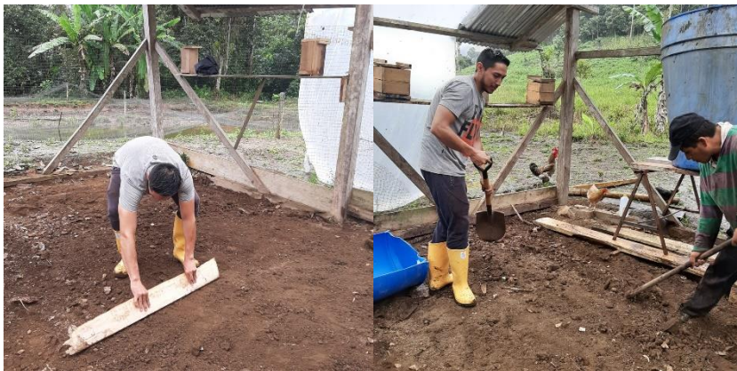
Figura 21. Nivelación del terreno
