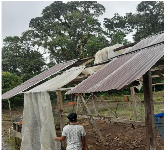
Figura 20. Adecuación de construcción para el estudio
