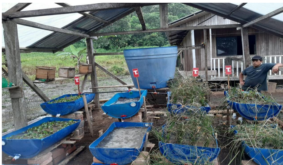
Figura 32. Planta de tratamiento
