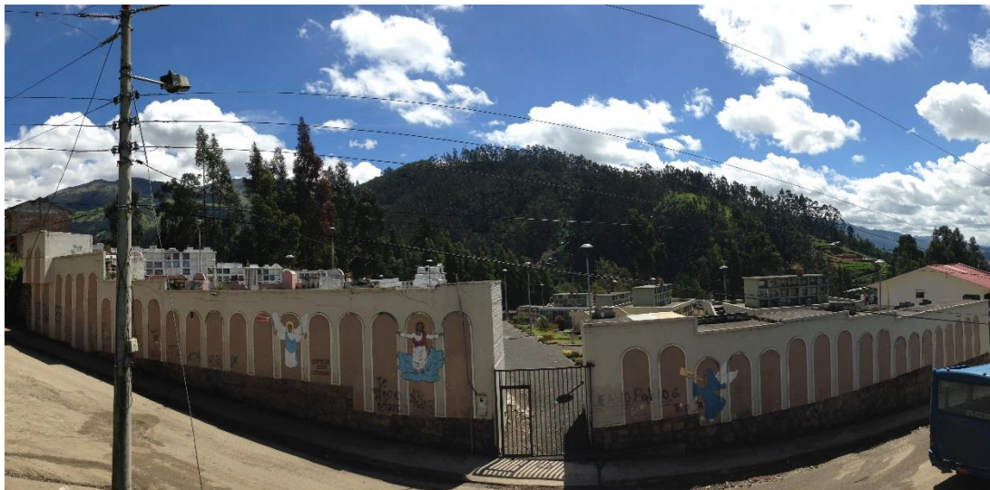
Ilustración 55 Panorámica del Cementerio Parroquial de Baños
