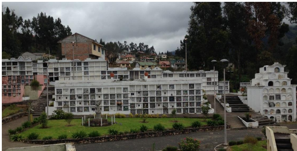
Ilustración 67 Zona oeste del Cementerio Parroquial de Baños
