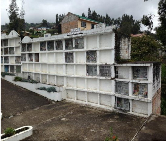
Ilustración 26 Bloque de bóvedas
