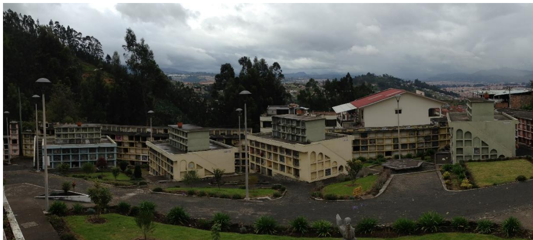
Ilustración 64 Zona este del Cementerio Parroquial de Baños
