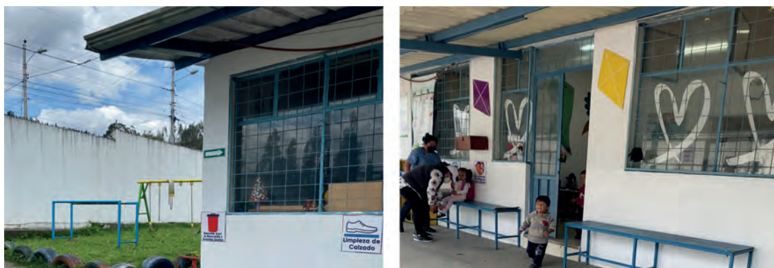
FIGURA 2.25: Levantamiento fotográfico del equipamiento de bienestar social
