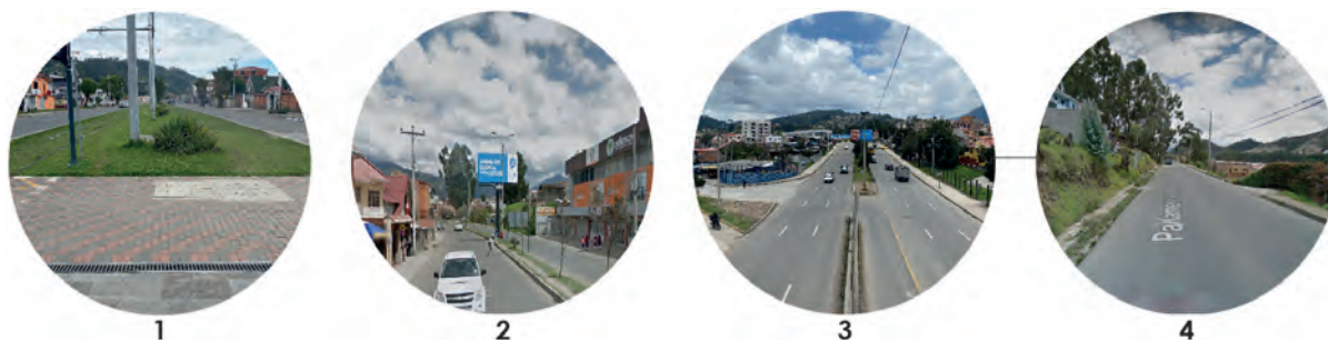
FIGURA 2.11: Estado de vías principales
