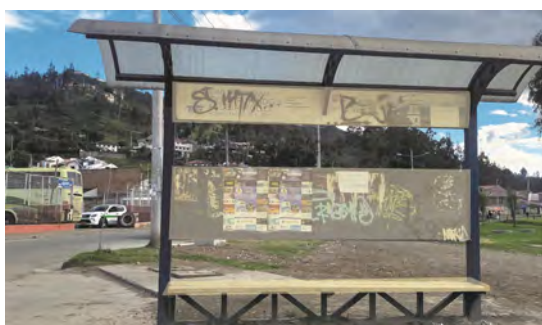
Fuente: Levantamiento in situ Elaboración: Autoras
