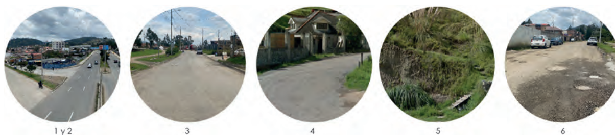
FIGURA 2.43: Levantamiento fotográfico del estado de las vías
