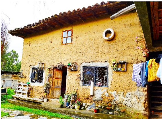
Foto N°38. Detalles de la materialidad de la edificación
