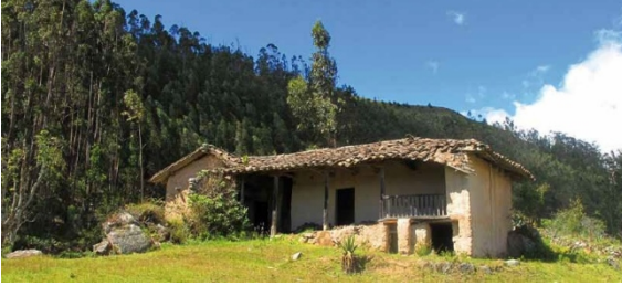
Foto N° 20: Casa ubicada en el sector Tarqui de Cuenca
