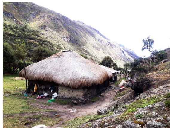
Foto N° 15: Casa en el pueblo de Patul, sector El Cajas
