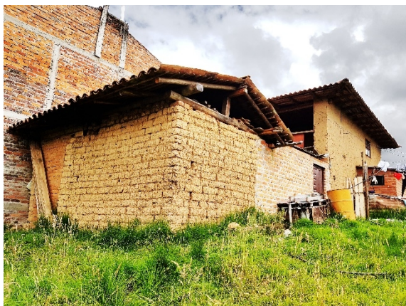
Foto N°41. Materialidad de la edificación
