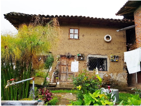
Foto N35°. Elevación lateral de edificación a ser intervenida.
