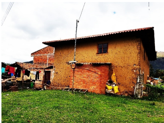
Foto N°36. Elementos constructivos adicionados a la Tipología original de la edificación.
