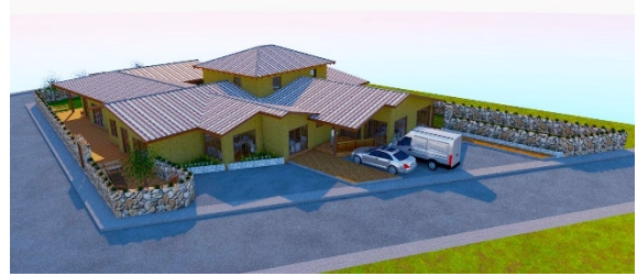
Plano N°9. Perspectiva aérea de la edificación intervenida.
