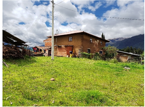
Foto N°39. Materialidad de la edificación
