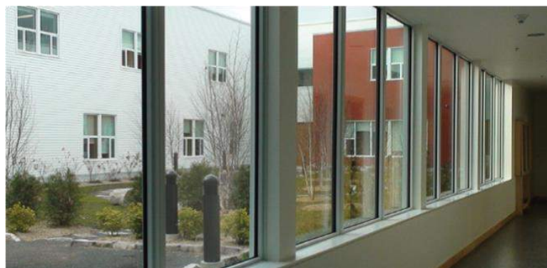
Imagen 18. Transparencia en caras del proyecto Fuente: https://formstudioinc.ca/projects/sjcg-sister-margaret-smith-centre-leed-
