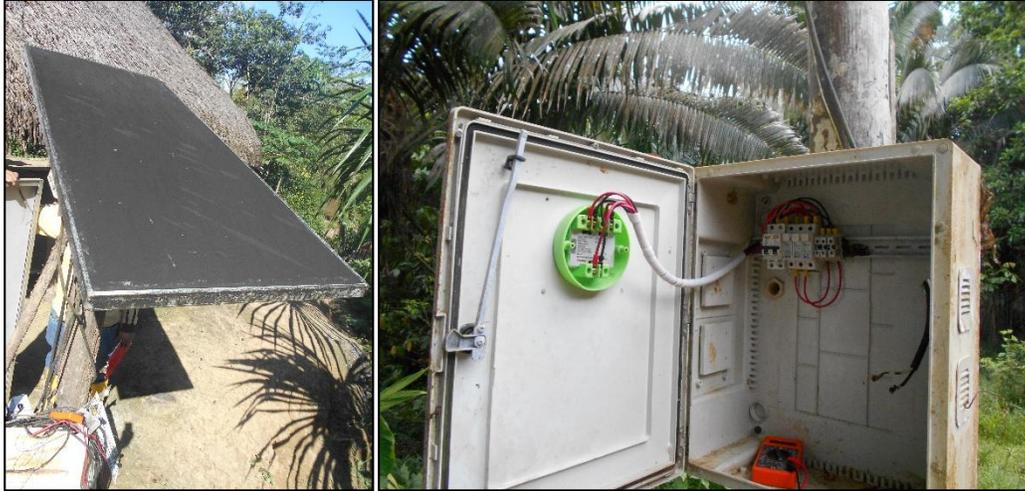
*Ilustración 15. Sistema de paneles solares fotovoltaicos instalados obsoletos, en desuso y destruidos
