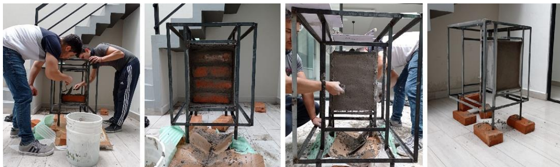
FIGURA 2.25: Colocación de Mampostería
