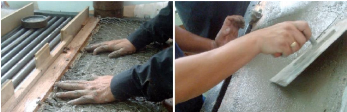
FIGURA 1.27: Proceso de Elaboración del Panel
