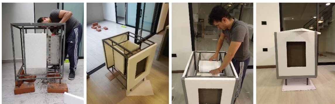
FIGURA 2.26: Instalación de Paredes de EPS
