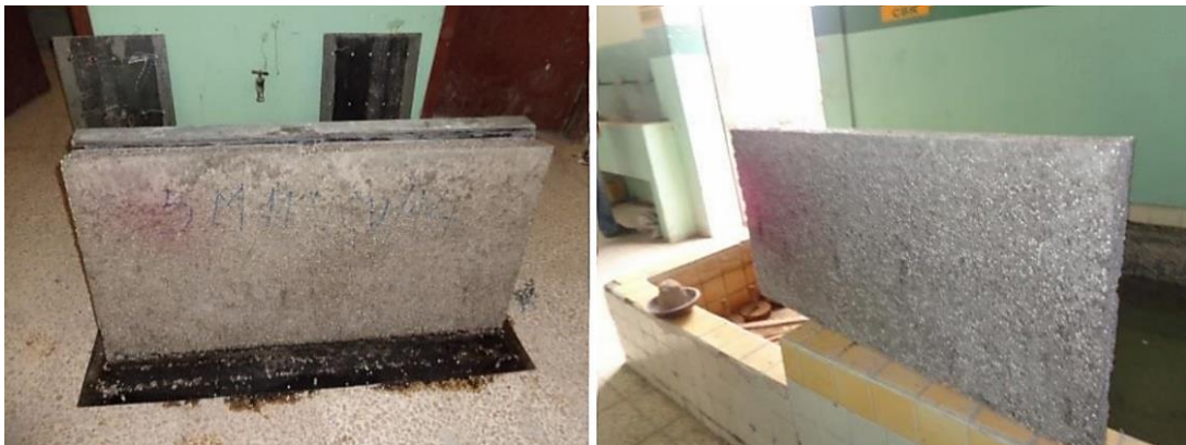
FIGURA 1.19: Muro Prefabricado Terminado
