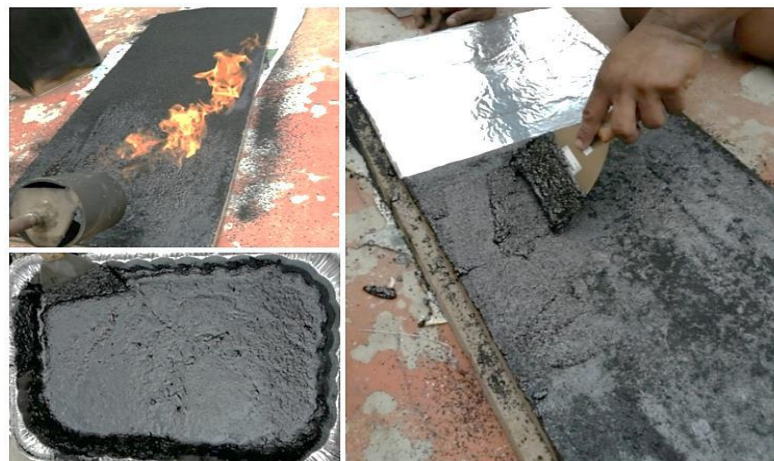
FIGURA 1.16: Impermeabilización de la Placa
