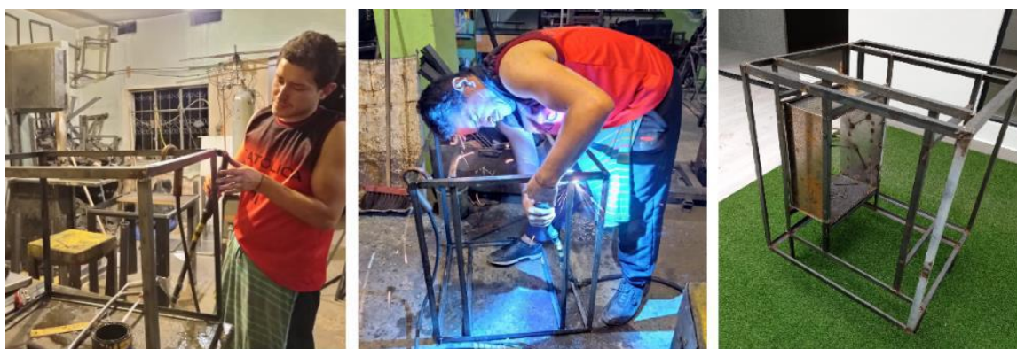
FIGURA 2.24: Fabricación de Estructura Metálica.
