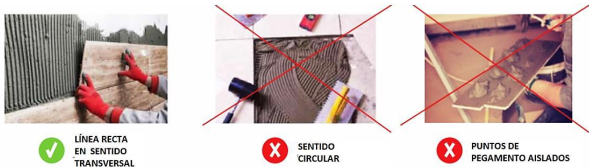
FIGURA 1.23: Forma Correcta de Colocar Pegamento Cementicio y Placa ZATOH
