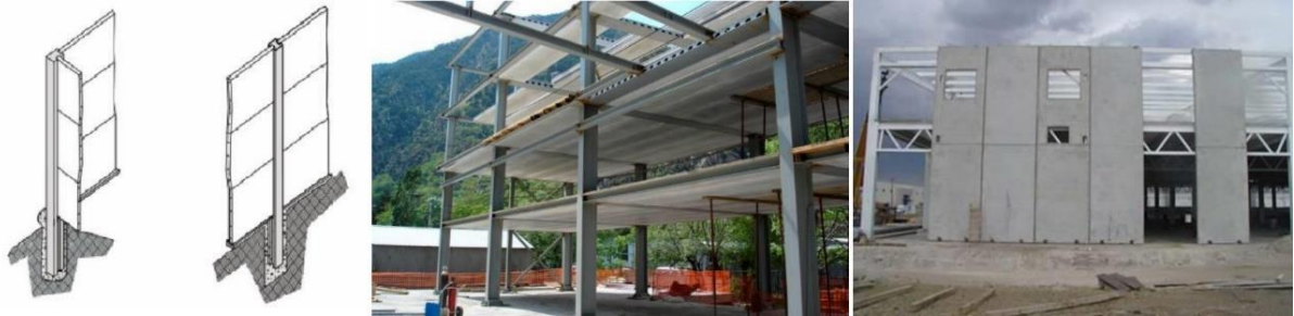
FIGURA 1.20: Instalación y Montaje en Obra del Muro Prefabricado
