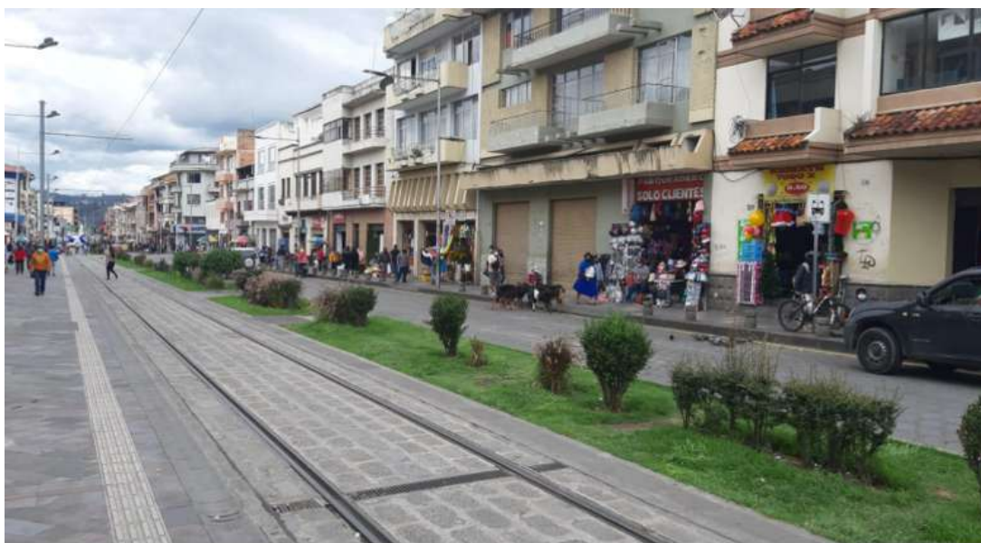
FIGURA 1.9: Deterioro de la imagen urbana pro presencia de comercio informal en la calle Gaspar Sangurima. Fuente: Propia
