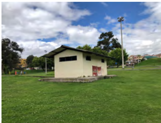
FIGURA 2.5: Servicios Sanitarios. Fuente: Fotografías tomadas por los autores
