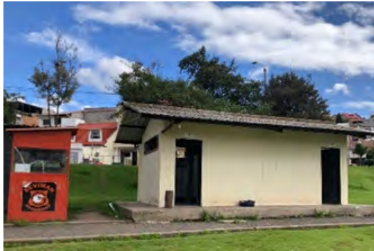
FIGURA 2.39: Se observa que los sanitarios le hace falta mantenimiento y darle un mejor aspecto, ya que por el momento son los únicos que funcionan para el uso propio de las personas. Además que cuenta con un puesto de seguridad muy pequeño para el resguardo de las personas. Fuente: Villavicencio (2015)
