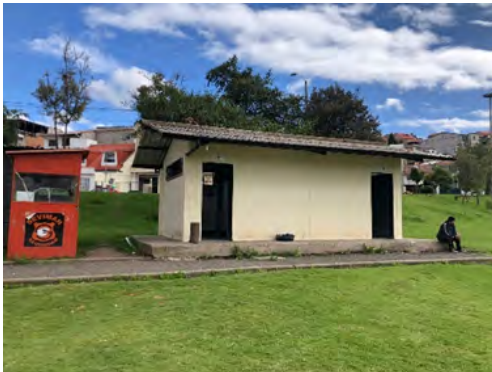
ESTADO ACTUAL DE BAÑOS
