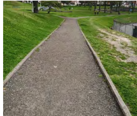
ESTADO ACTUAL DE SENDEROS
