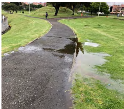
Estado actual de senderos
