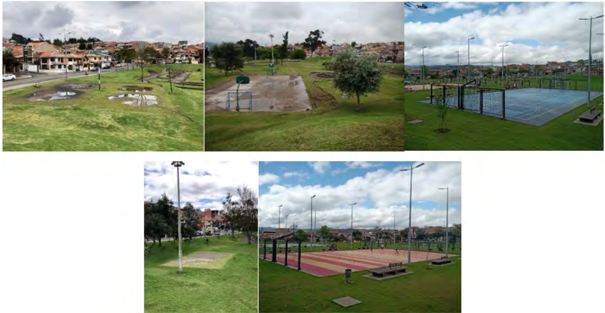
FIGURA 2.45: Se observa en las tres primeras fotos que las canchas se encuentran en mal estado, llegando a causar por el deterioro empozamientos y crecimiento de hiervas dentro de estas, por otro lado las otras canchas que se encuentran en las imágenes de la parte inferior están ubicadas en la parte este del parque y están en buenas condiciones ya que fueron contruidas recientemente y son las mas utilizadas por los usuarios del sector. Fuente: Fotografías tomadas por los autores.
