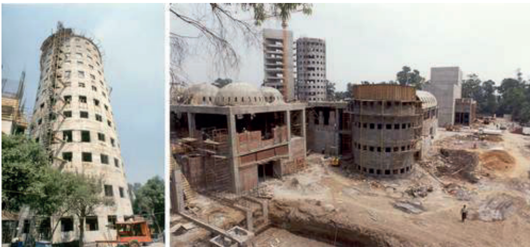
FIGURA 2.31: Aspectos de la construcción del complejo cultural
