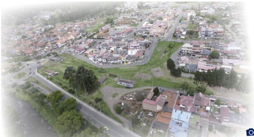
FIGURA 3.35: Perspectiva aérea de la infraestructura
