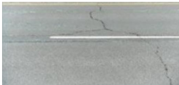
FIGURA 6.-FISURAS TRANSVERSALES
