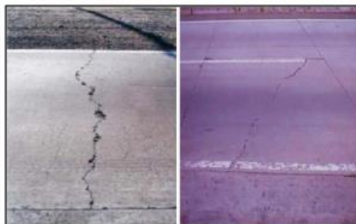
FIGURA 15.-GRIETAS TRANSVERSALES
