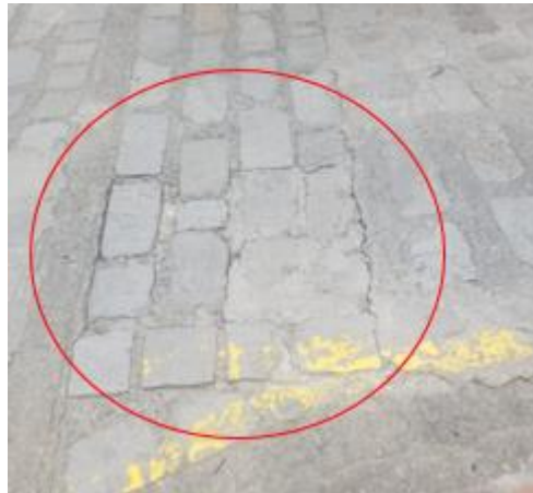
FIGURA 58.-DESPLAZAMIENTO DEL PAVIMENTO ARTICULADO
