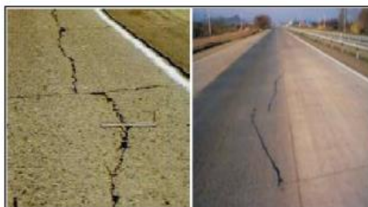
FIGURA 14.-GRIETAS LONGITUDINALES
