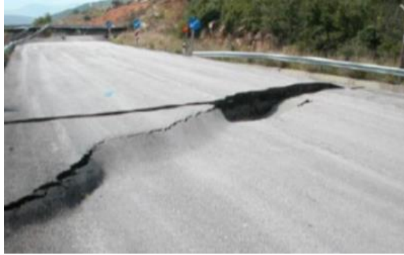
FIGURA 4.-HUNDIMIENTO
