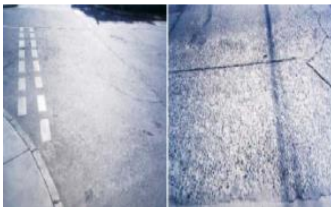
FIGURA 18. DESINTEGRACIÓN
