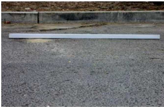
FIGURA 3.-AHUELLAMIENTO
