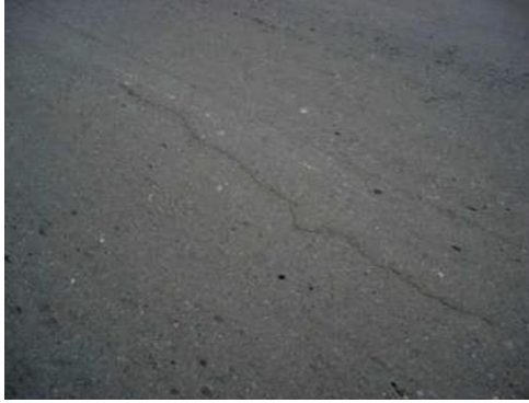
FIGURA 5.-FISURAS LONGITUDINALES
