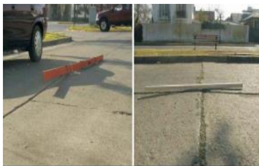
FIGURA 20.- LEVANTAMIENTO LOCALIZADO
