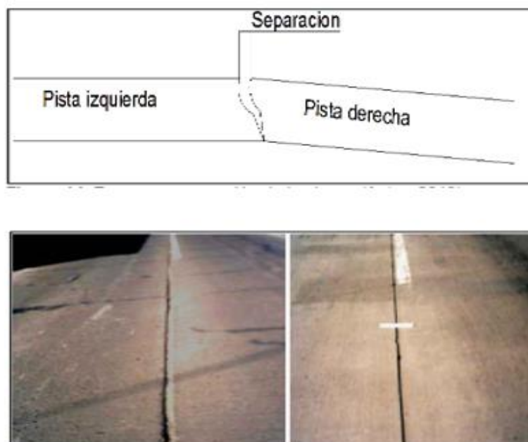
FIGURA 12.-ESQUEMA SEPARACIÓN DE LOSAS Y JUNTAS LONGITUDINALES
