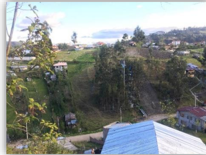
FOTOGRAFÍA 28: FALTA DE CONSERVACIÓN DE LOS RECURSOS NATURALES Y ECOLÓGICOS Fuente: Propia.
