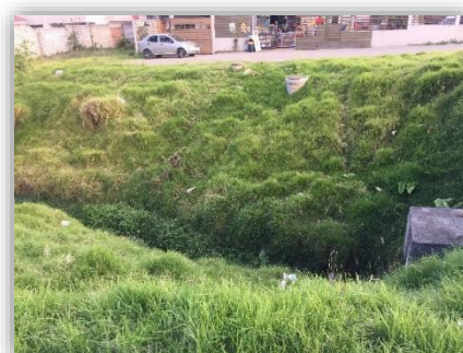
FOTOGRAFÍA 34: ESTADO DE VÍA OESTE. Fuente: Propia.
