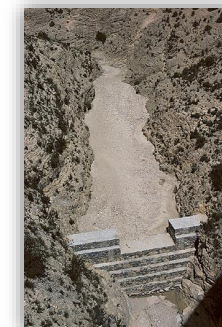
ILUSTRACIÓN 5: DIQUE EL BARRANCO DE LAS OVEJAS, ALICANTE Fuente: http://www.mapama.gob.es/es/ desarrollo-rural/temas/politica-forestal/desertificacion-restauracion-forestal/restauracion-hidrologico-forestal/rhf_caracteristicas_correccion_cauces.aspx
