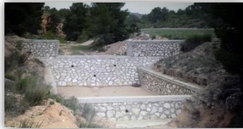
ILUSTRACIÓN 9: DIQUE EN MAMPOSTERÍA. Fuente: http://www.inerziaconstrucciones.com/galeria.htm
