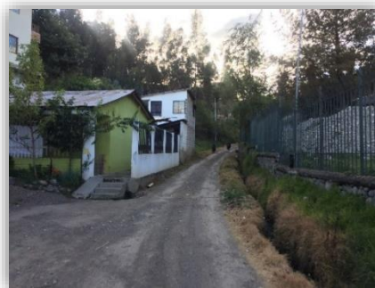
FOTOGRAFÍA 10: VISTA DEL INGRESO, TRAMO 1 Fuente: Propia.
