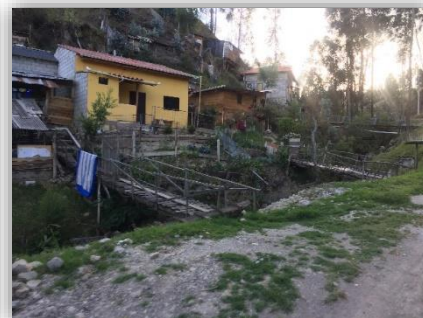
FOTOGRAFÍA 30: PUENTES IMPROVISADOS. Fuente: Propia.
