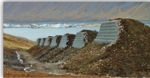
ILUSTRACIÓN 8: DIQUE DE HORMIGÓN ARMADO CON CUENCO DE SEDIMENTACIÓN PREVIA, CONSTRUIDO EN FRANCIA. Fuente: https://www.researchgate.net/figure/308208786_fig15_Figura-1124-Dique-de-hormigon-armado-con-cuenco-de-
