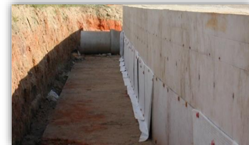
ILUSTRACIÓN 7: MURO MARGINAL DE UN TERRENO. Fuente: http://www.coripa.com.ar/caso-de-obra/16-plusdren-en-muros-de-contencion
