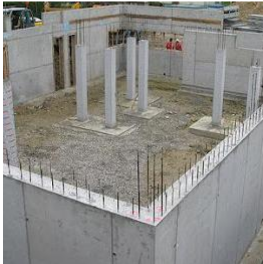
Figura 149: Sistema constructivo de muros de hormigón armado
