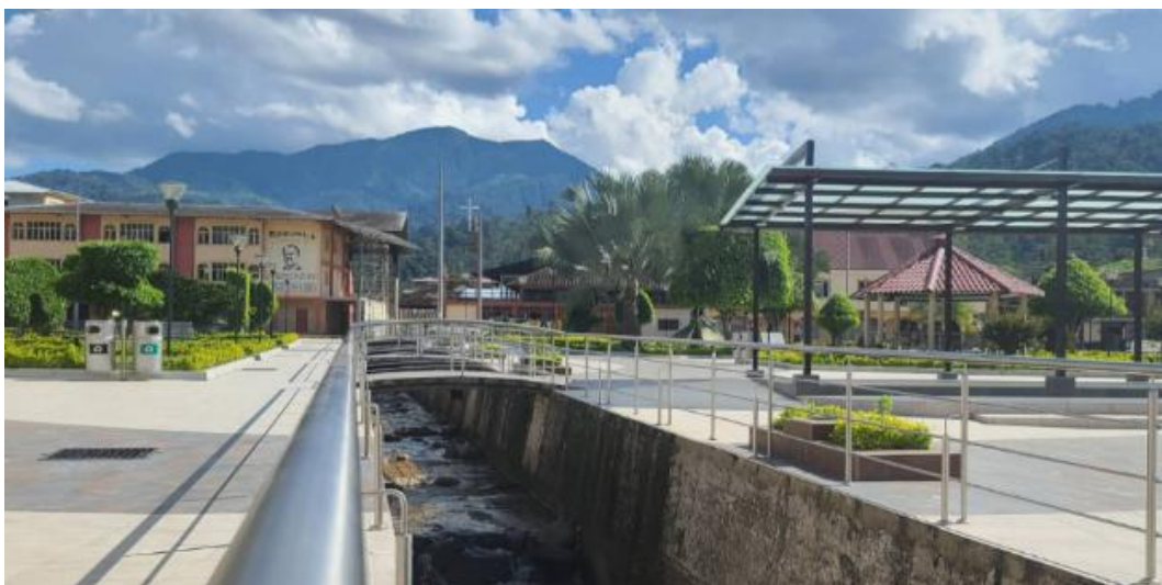
Figura 73: Quebrada con embaulamiento, atravesando el parque central.
