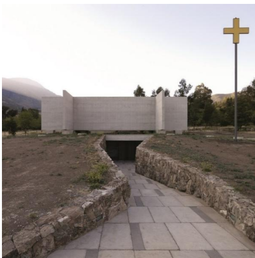
Figura 55: Exterior de la Capilla del Retiro
