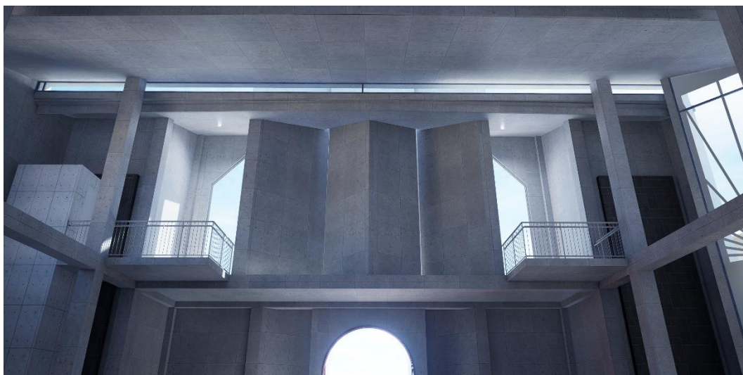
Figura 137: Vista desde la nave central hacia el campanario
