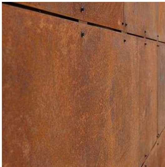
Figura 151: Pátina oxidada natural del acero corten
