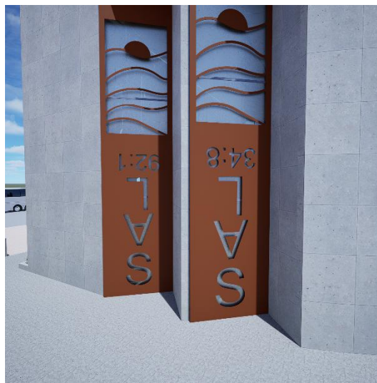
Figura 154: Acero corten con figuras y citas bíblicas grabadas en sus paneles
