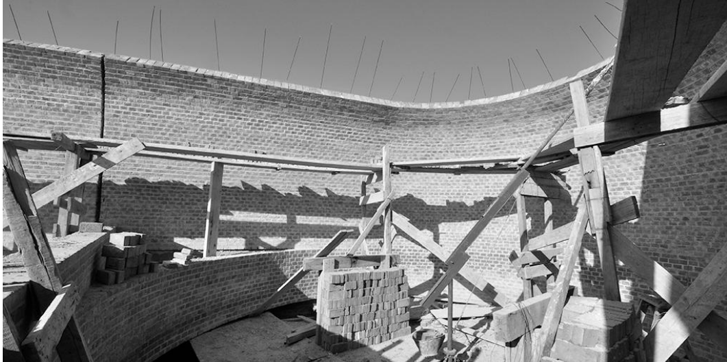
Figura 54: Construcción de aparejo de ladrillo en el muro curvo.
