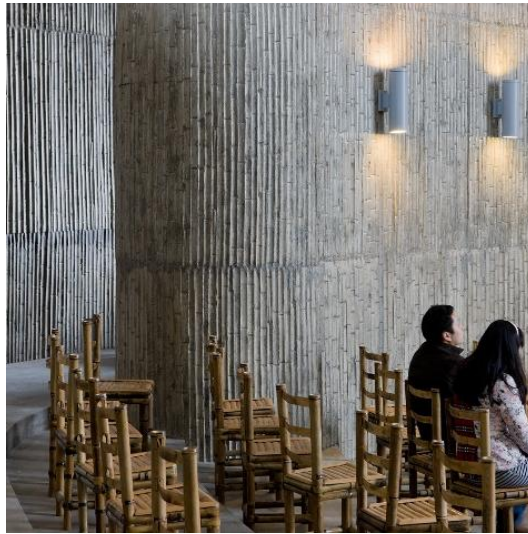
Figura 48: Muros con textura de encofrado de bambú.
