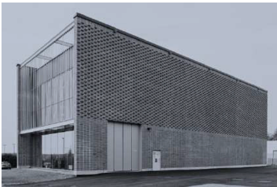
Figura 10 Edificio bomba de calor vuossari.
