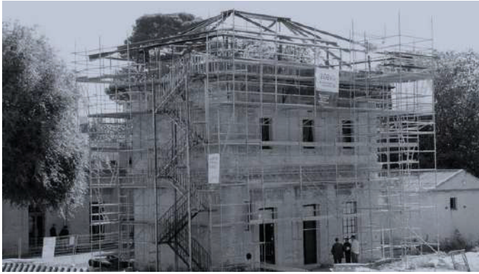
Figura 15 - Restauración de un edificio patrimonial, Toledo. Fuente: ArchDaily.
