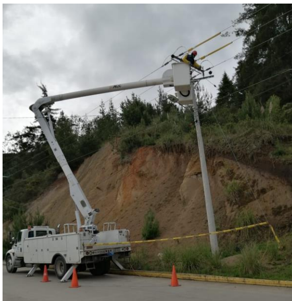
Montaje de estructura
