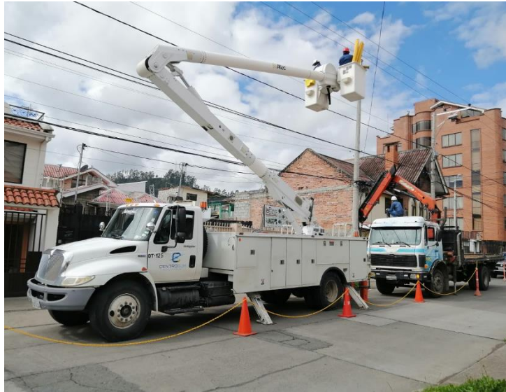
Reubicación de poste.
