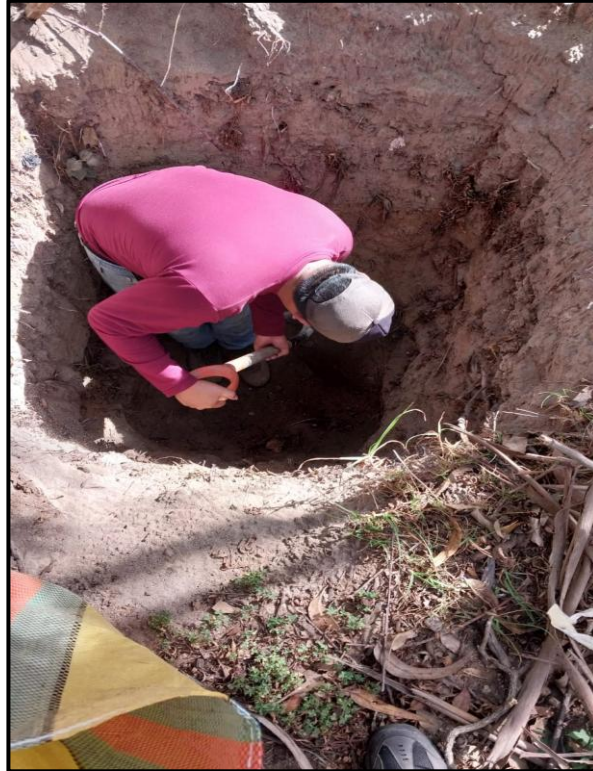
Figura 16 Excavación de la calicata.
