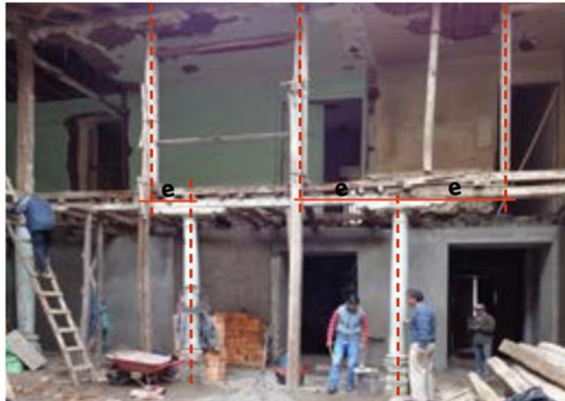
Figura 19. Excentricidad en pórticos.
