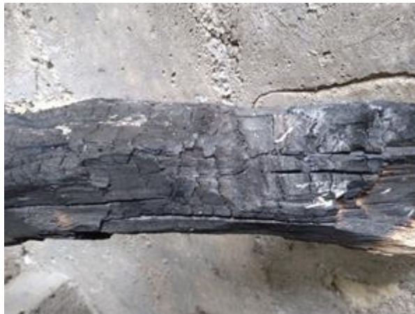
Figura 11. Acción del fuego en la madera.
