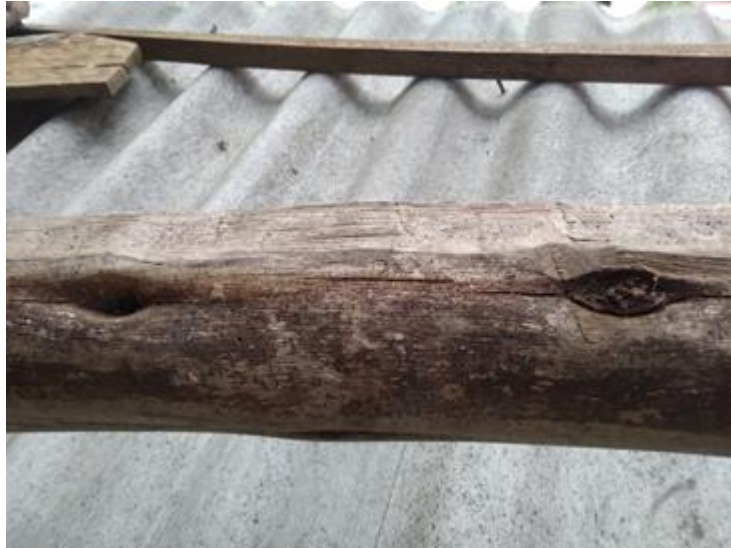
Figura 9. Presencia de Nodos en Estructuras.
