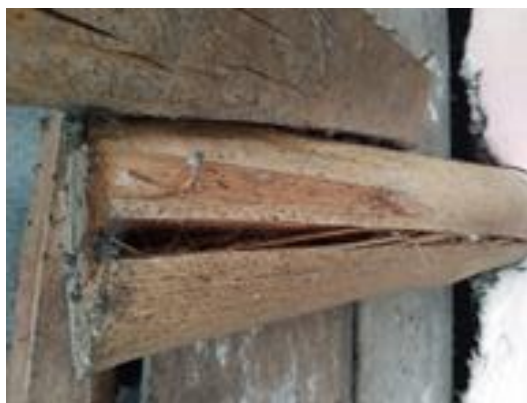
Figura 10. Agrietamiento.
