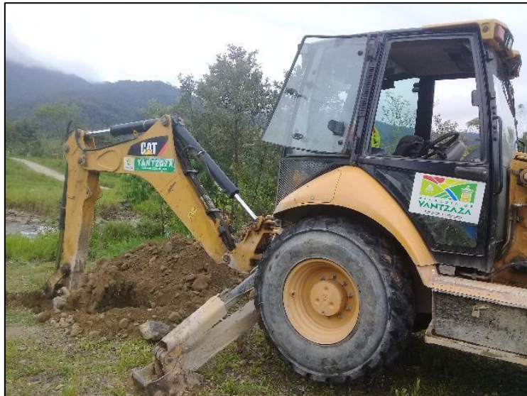
Figura 44. Excavación en la ubicación del estribo Oeste. Elaborado: Autor
