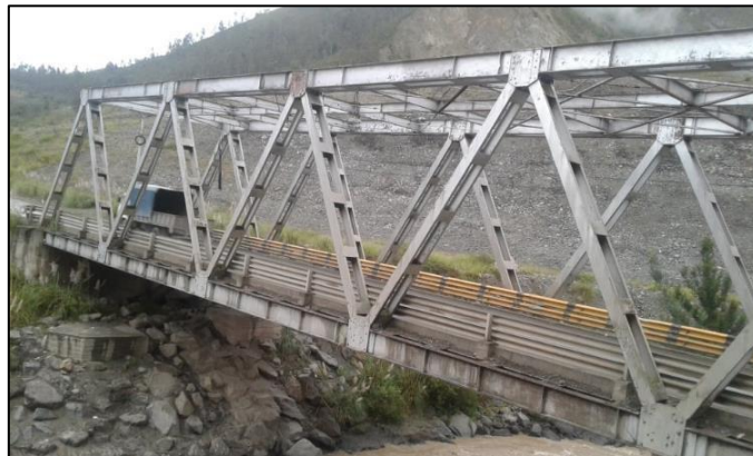
Figura 1. Puente Carrozable Mixto (Hormigón-Acero) sobre el río Paute; La Josefina, Azuay. Elaborado: Autor.
