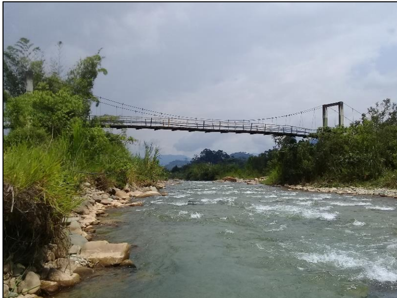
Figura 2. Puente Peatonal sobre el río Chicaña; San Vicente, Chicaña, Yantzaza Fuente: Autor.
