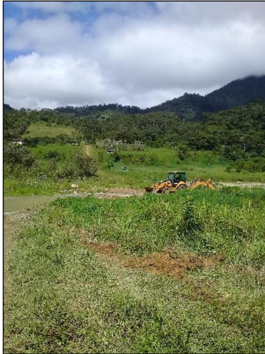
Figura 42. Retro Excavadora en el sitio de ubicación del puente. Elaborado: Autor
