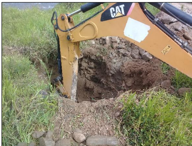
Figura 43. Excavación en la ubicación del estribo Este. Elaborado: Autor
