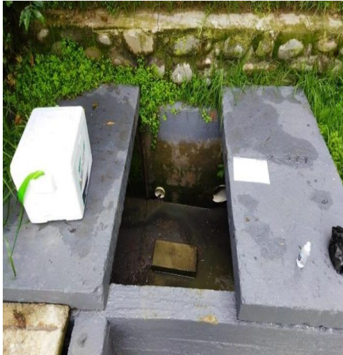
Figura 7: Desarenador de la PTAR "Laureles" de la parroquia Santa Ana.
