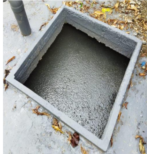
Figura 8: Fosa de lodos de la PTAR "Laureles" de la parroquia Santa Ana.
