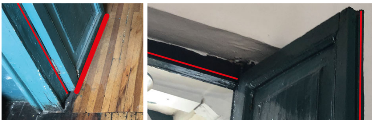
FIGURA 3.12: Colocación de burletes en puerta edificación BC_s. Fuente y elaboración: Autor
