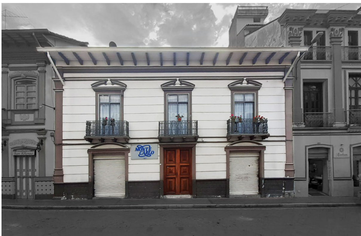
FIGURA 2.13: Fachada y relación con el entorno edificación CA.e. Fuente y elaboración: Autor
