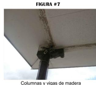
Columnas y vigas de madera
