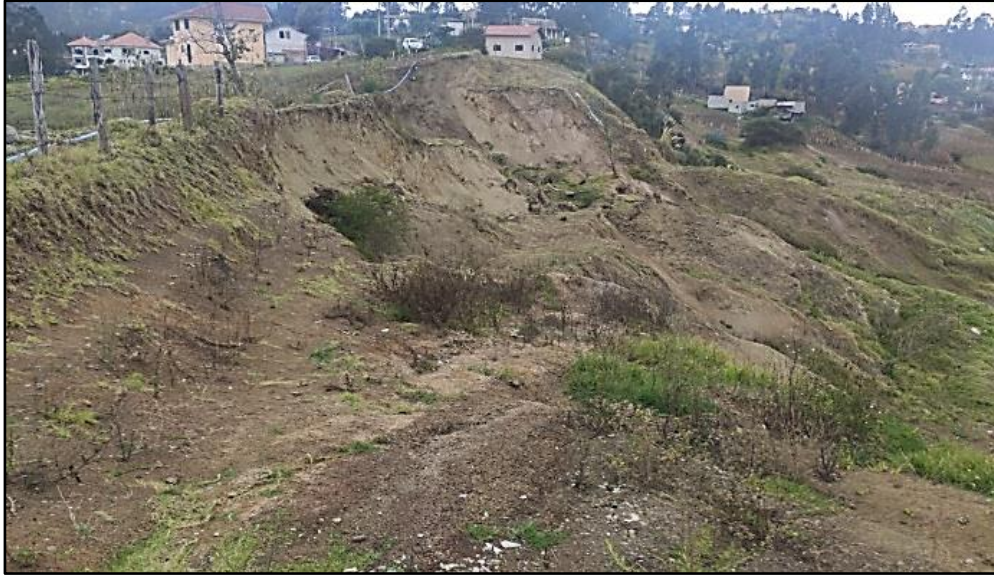
Ilustración 3 Talud objeto de estudio. Fuente: Elaboración propia.
