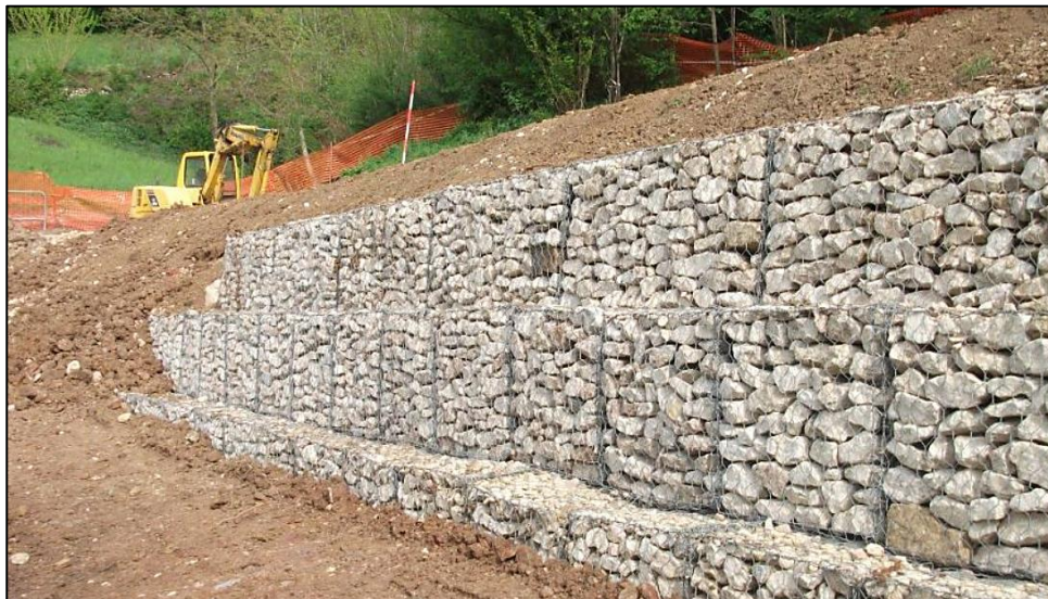
Ilustración 23: Muro de contención tipo gaviones.
