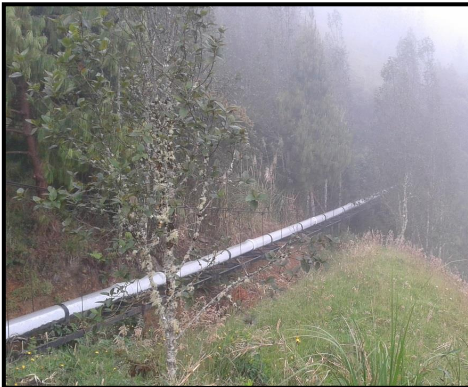
Foto 1 Puente de la conducción actual.
