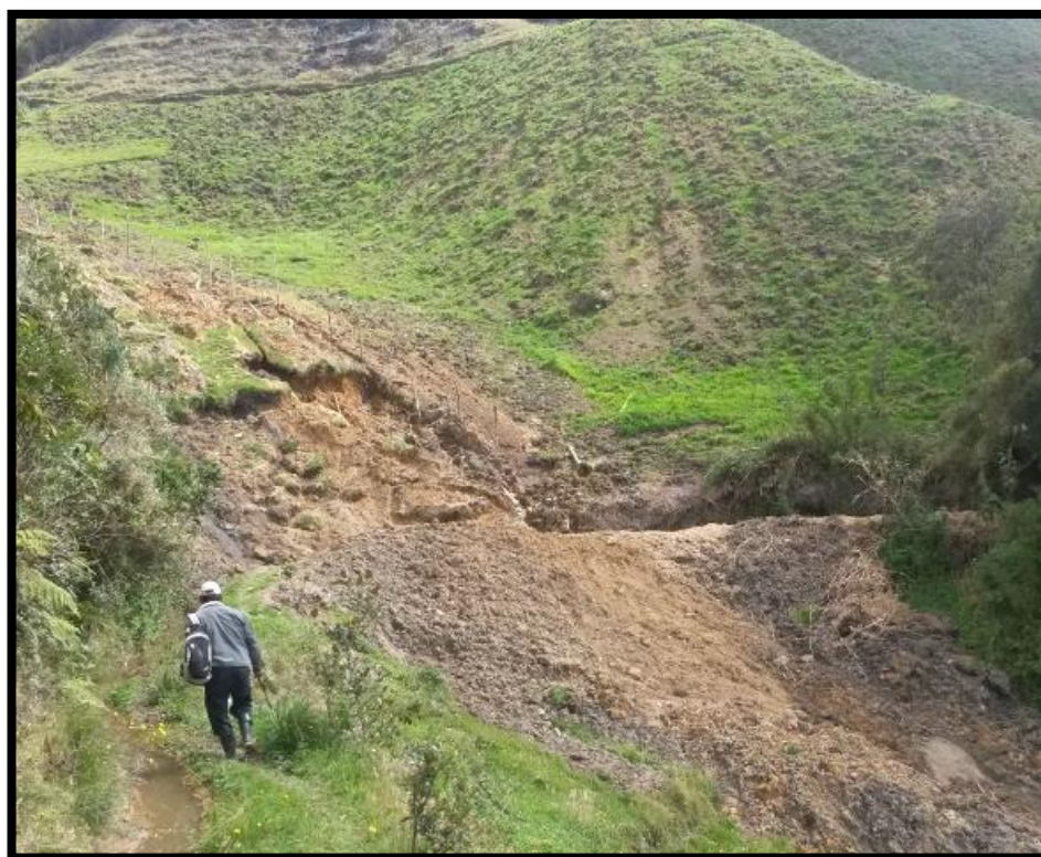
Foto 2 Derrumbe sobre la Conducción (Longitud Este 756397, Latitud Norte 968921)
