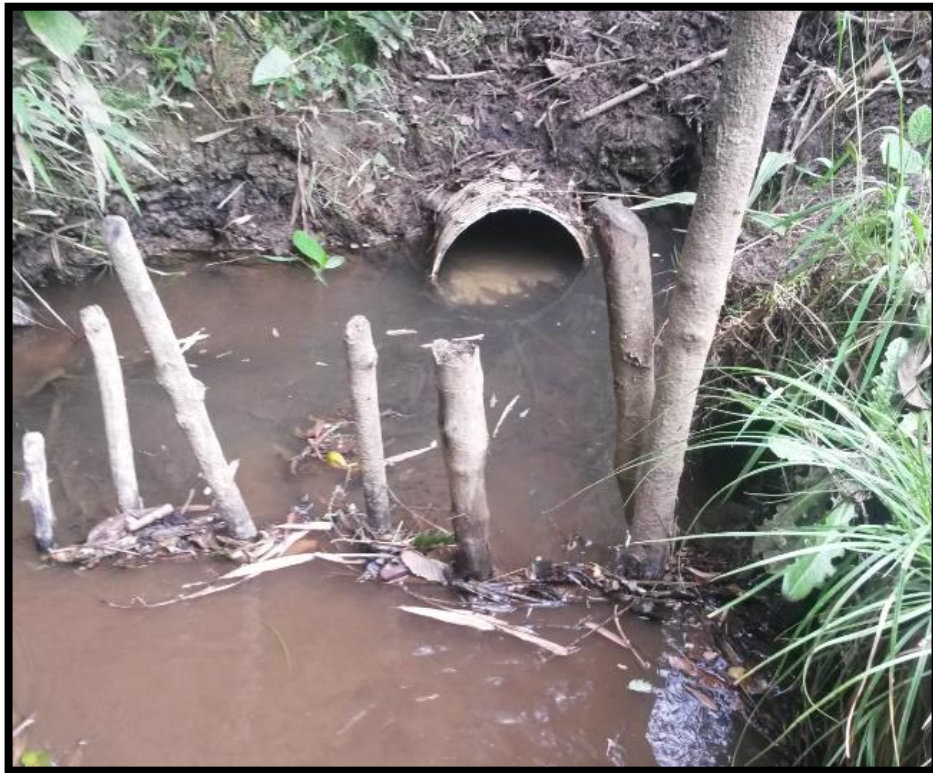
Foto 3 Cambio de material en la Conducción.
