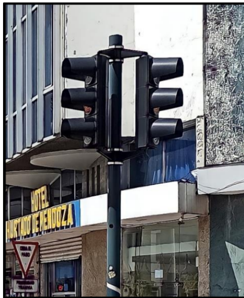
Figura 90: Semáforo de tres tiempos existente fuente: autores
