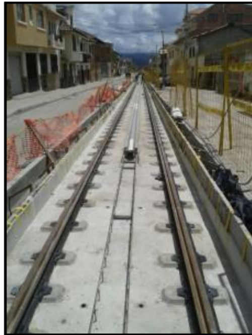
Figura 50: Sistema APS de Alstom aplicado en Cuenca fuente: https://www.trenvista.net
