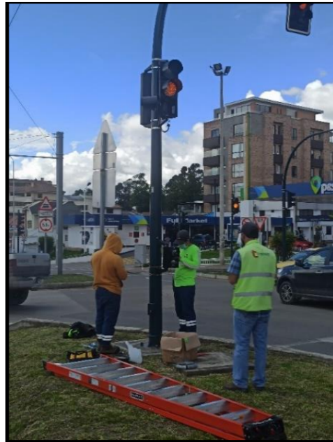
Figura 66: Colocación de semaforización auxiliar en el Redondel Simón Bolívar fuente: autores
