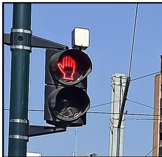
Figura 91: Semáforo de cruce peatonal existente fuente: autores
