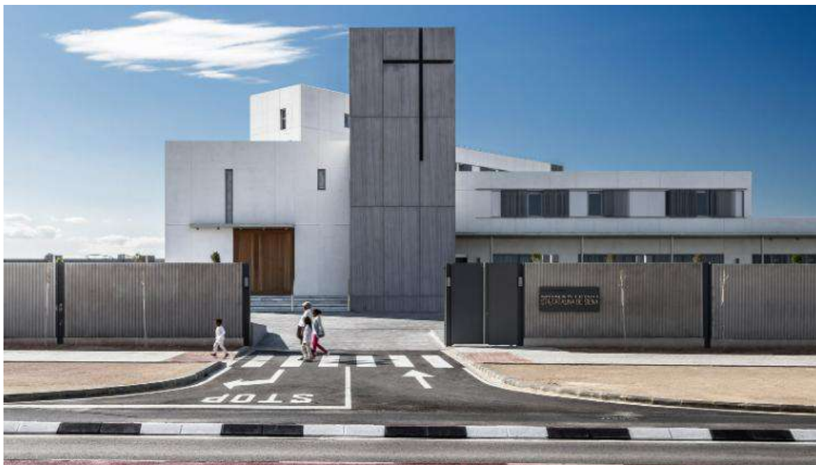
Figura 35: Real Monasterio de Santa Catalina de Siena / Hernández Arquitectos
