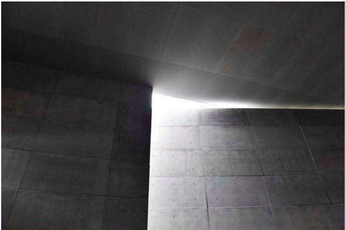
Figura 33: Materialidad: Hormigón pulido en la Iglesia de la luz.
