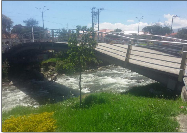
Figura 6. Puente peatonal en estructura metálica, Otorongo Cuenca. Elaborado por: Autor
