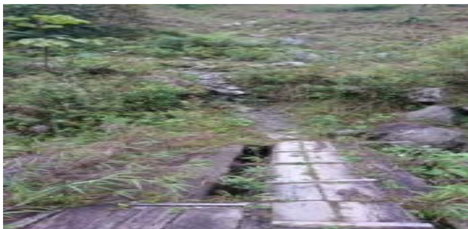
Figura 31. Margen izquierdo y derecho de la ubicación del puente. Elaborado por: Autor
