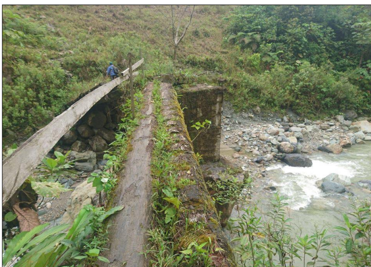
Figura 12. Puente provisional sobre el Río Yavintza. Elaborado por: Autor
