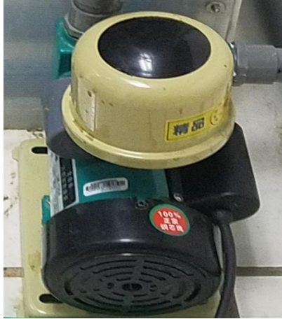
Fig. 11. Bomba de recirculación
