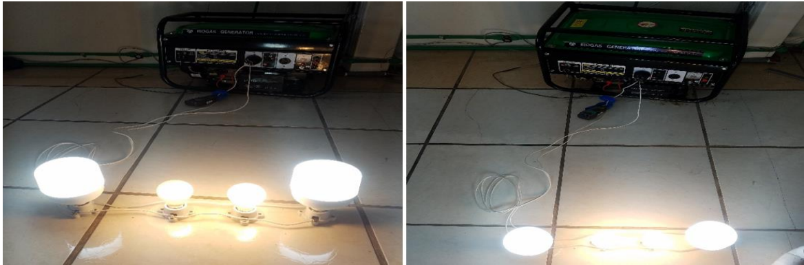
Fig. 29. Encendido del generador
