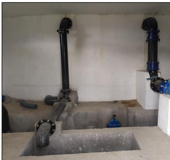
*Ilustración 31: Sistema de rebose con tubería 150 mm.*
