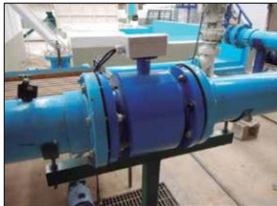
*Ilustración 20: Medidor Electromagnético [28].*
