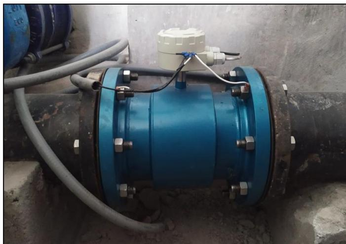
*Ilustración 29: Macromedidor tipo Electromagnético instalado*
