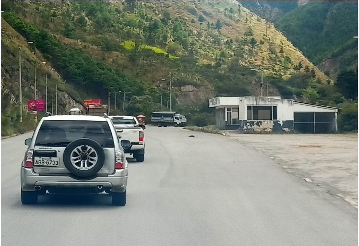
Figura 2: Deterioro del Antiguo Peaje de Chaquilcay.
