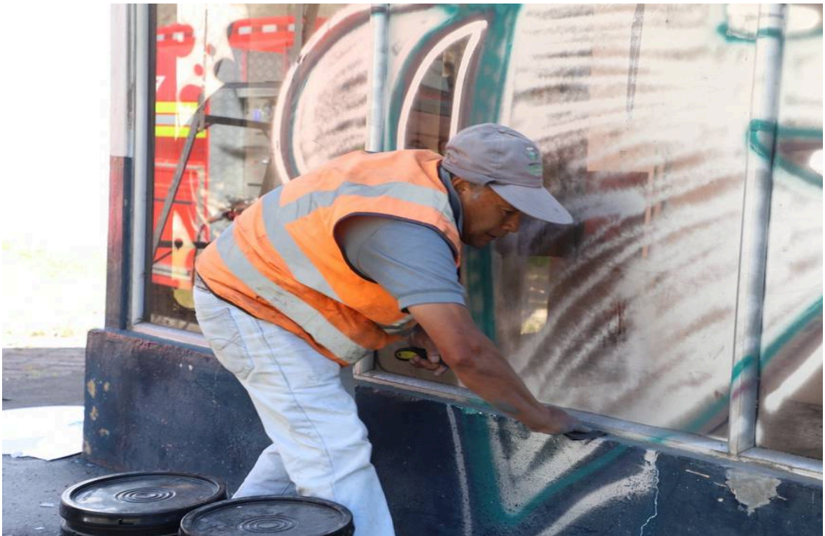
Figura 3: Trabajos para recuperar el Antiguo Peaje.
