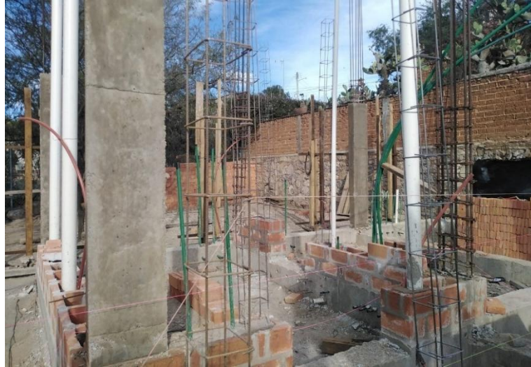
Figura 71: Construcción de Casa Finlandia
