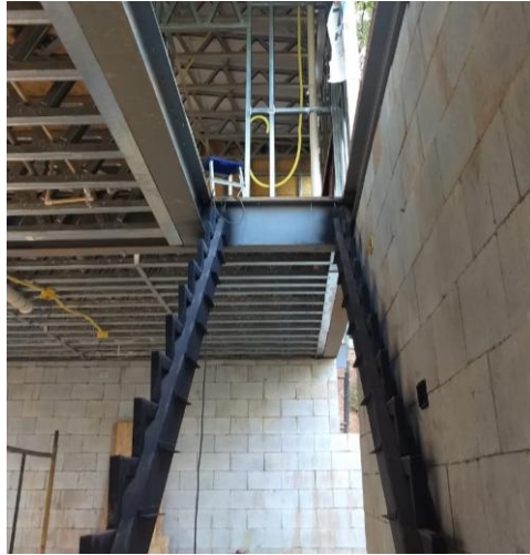
Figura 31: Construcción de escaleras de la Casa Pasargada
