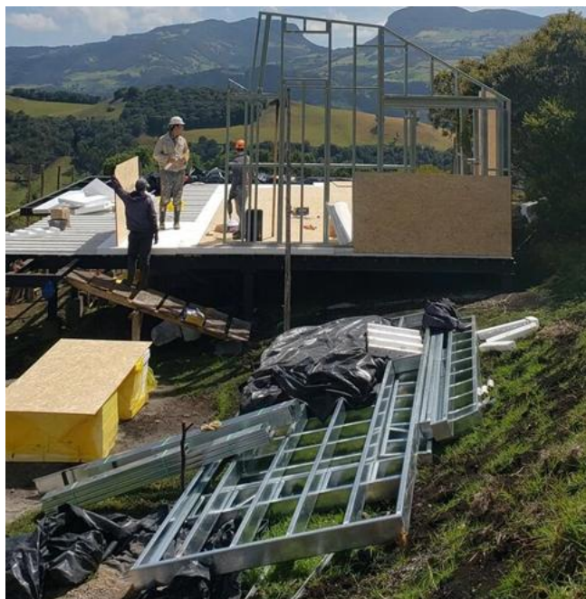
Figura 57: Construcción de Casa Carupa
