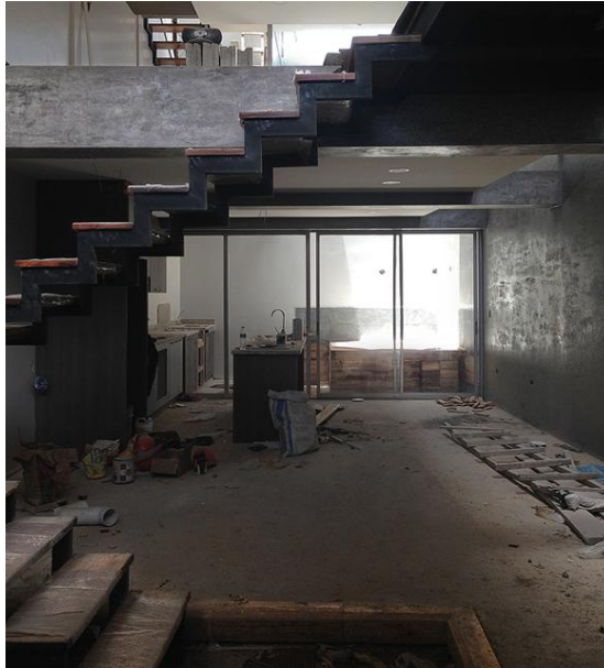
Figura 44: Construcción de escaleras de Casa Mashar
