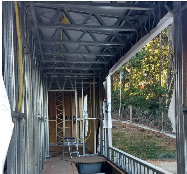
Figura 30: Construcción de la Casa Pasargada
