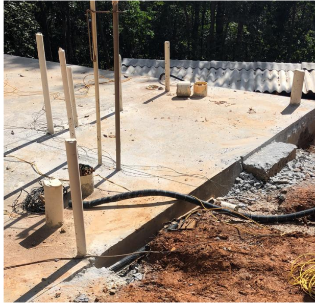
Figura 29: Construcción de la Casa Pasargada
