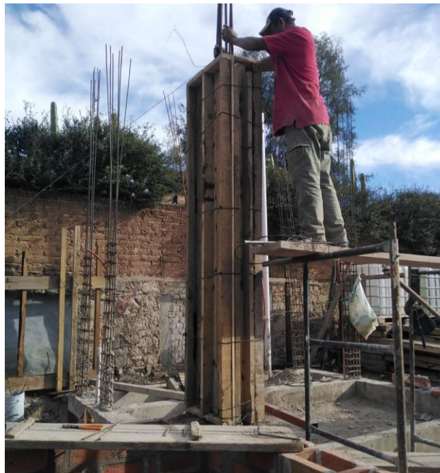
Figura 72: Construcción de Casa Finlandia
