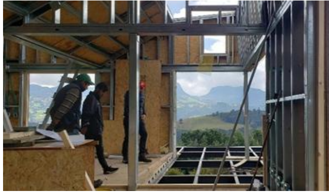
Figura 59: Construcción de Casa Carupa
