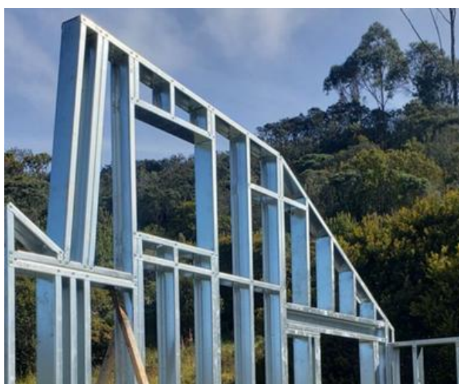
Figura 58: Construcción de Casa Carupa
