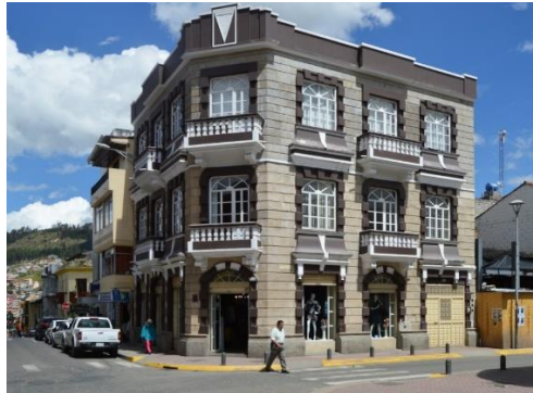
Fotografía N° 8: Edificación Patrimonial (6 – T1) Capturada por: Jonnathan Vázquez
