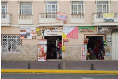
Fotografía N° 1: Excesiva colocación de publicidades para locales Capturada por: Jonnathan Vázquez
