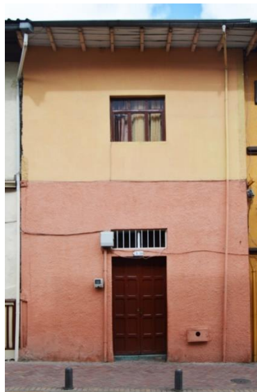
Fotografía N° 10: Edificación Patrimonial (36 – T8) Capturada por: Jonnathan Vázquez
