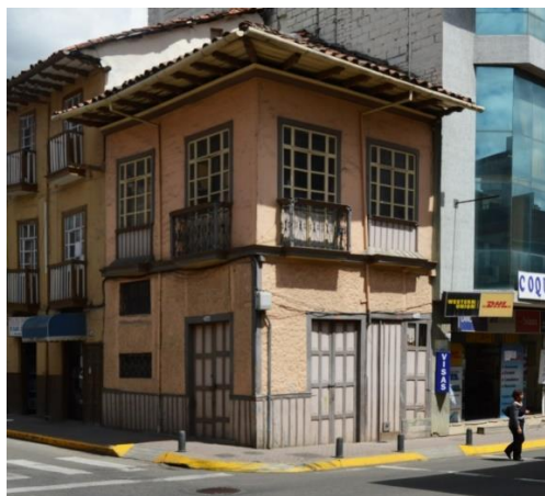
Fotografía N° 9: Edificación Patrimonial (9 – T2) Capturada por: Jonnathan Vázquez
