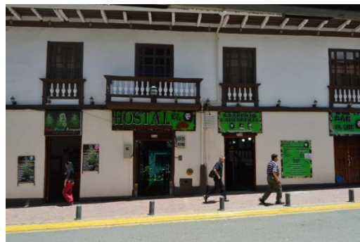
Fotografía N° 6: Excesiva colocación de publicidades en fachadas Capturada por: Jonnathan Vázquez
