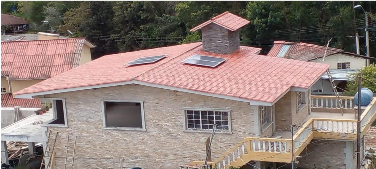
Figura 91. Paneles fotovoltaicos ubicados en la cubierta de la vivienda. Fuente: Los autores.
