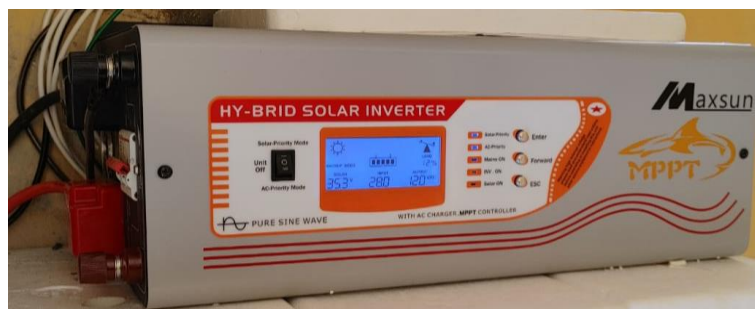
Figura 51: Inversor Maxsun de 2 Kva utilizado en la residencia realizado el proyecto de grado.
