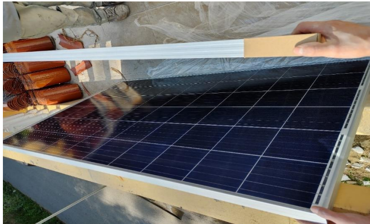
Figura 65. Se realizó la medición de los paneles fotovoltaicos. Fuente: Los autores.
