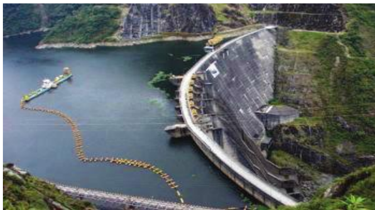
Figura 2. Central Hidroeléctrica Paute - Ecuador
