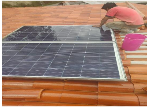
Figura 49. Mantenimiento de paneles fotovoltaicos en una residencia. Fuente: Los autores
