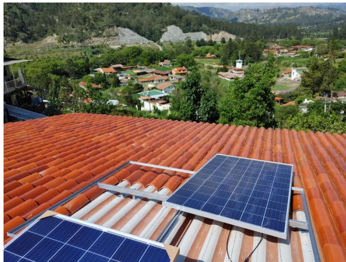
Figura 50. Soporte de aluminio el cual se colocarán las placas fotovoltaicas. Fuente: Los autores
