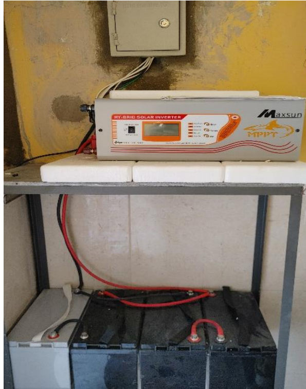
Figura 95. Cuarto de máquinas donde llega nuestro conductor. Fuente: Los autores.
