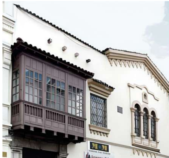
Figura 106: Fachada de la Casa Malo Moscoso.
