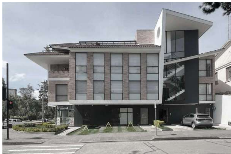
Figura 63: Edificación contemporánea tradicional en Cuenca.
