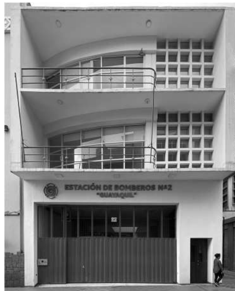
Figura 52: Fachada del Cuartel de Cuerpo de Bomberos.
