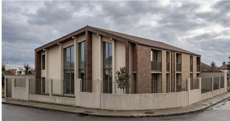
Figura 209: Visualización exterior de la Casa E18 (Fachada frontal).
