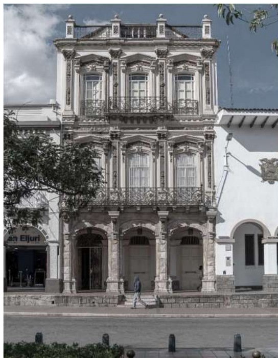
Figura 33: Fachada de la antigua Casa Ordóñez Jerves, actual Pasaje Hortensia Mata.
