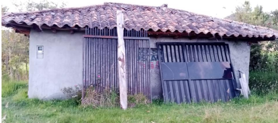
Fig. 22 Casa rustica de adobe.
