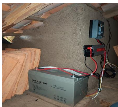
Fig. 29 Conexión del controlador a la batería e inversor.
