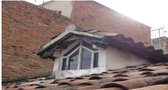
Fotografía No. 4 Ventana de la buhardilla
