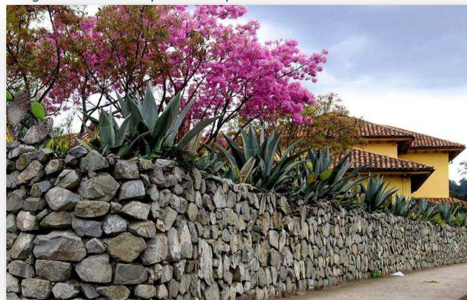
Imagen 104 Muro de piedra con penos tradicional de la Quinta BOLIVAR
