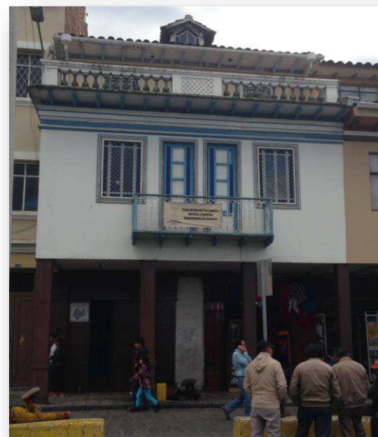
Imagen 128 Fachada frontal de la edificación Casa de los Deberes y Derechos
