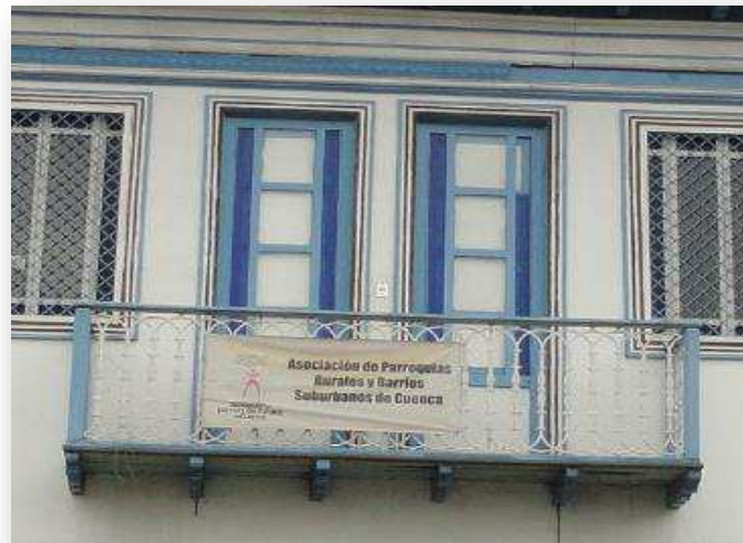
Fotografía No. 15 Balcón del ambiente 2(AD 78)
