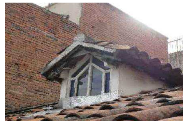
Fotografía No. 25 Cubierta de la parte frontal de la edificación.
