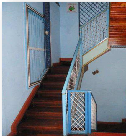
Fotografía No. 21 Escalera con ventana tapiada 2(AC 45)
