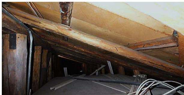
Fotografía No. 3 Estructura de madera de la cubierta
