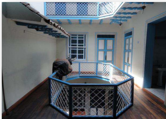
Fotografía No. 19 Ventana del ambiente 2(BD 12)
