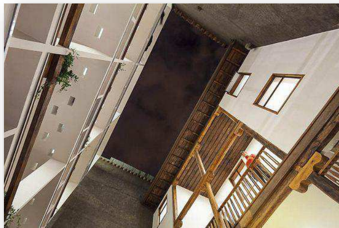
Imagen 86 Edificación patrimonial y Obra nueva
