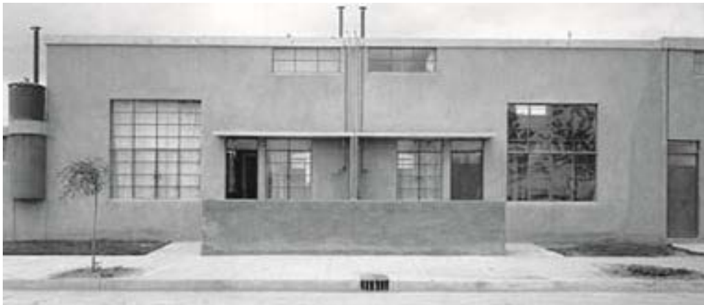
Figura 1.52: Fotografía a blanco y negro de la fachada del proyecto Vivienda Obrera de Juan Legarreta
