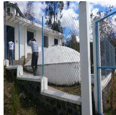
Fotografía #3 – Tanque Almacenamiento
