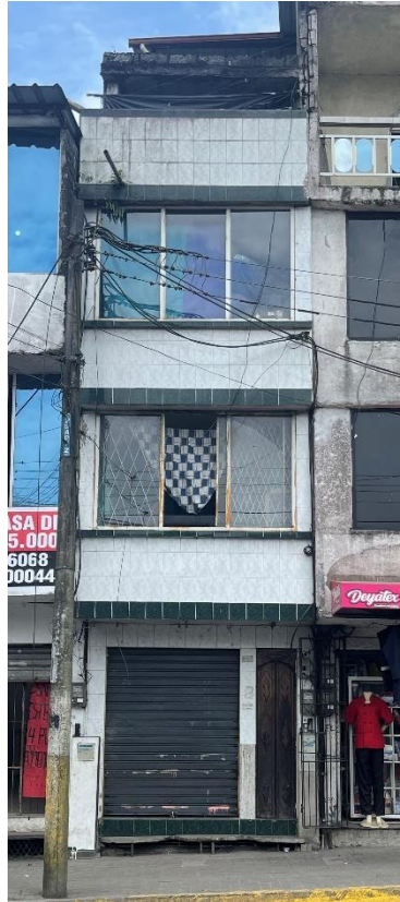
Anexo 91. Sin juntas constructivas
