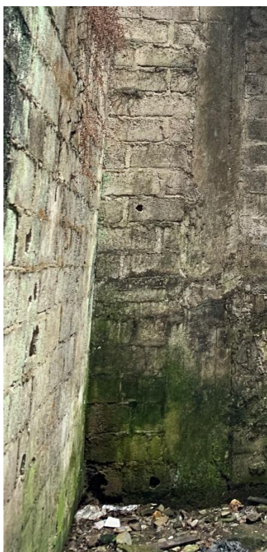
Anexo 20. Sin juntas constructivas
