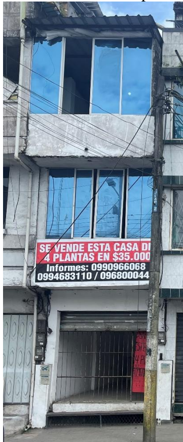
Anexo 81. Sin juntas constructivas
