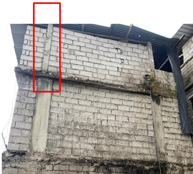
Anexo1. Columnas superiores de menor dimensión
