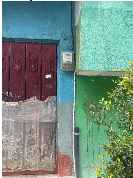
Anexo 113. Sin junta constructiva
