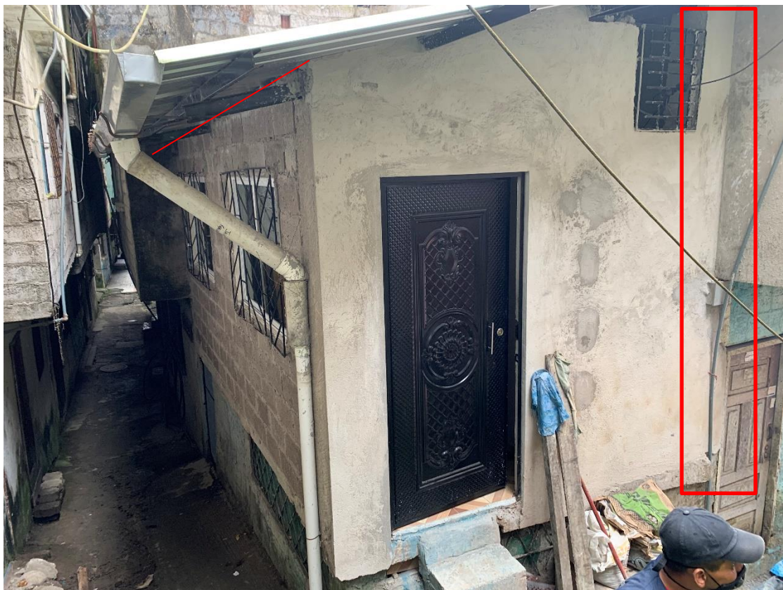
Anexo 8. Confinamiento de mampostería y junta constructiva
