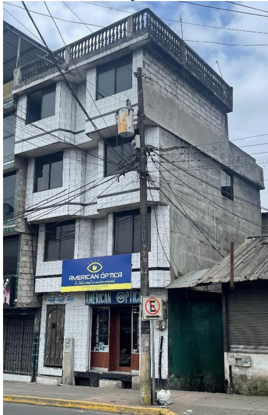
Anexo 109. Presencia de humedad y moho
