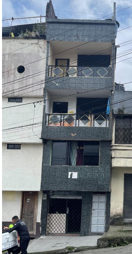
Anexo 61. Sin juntas constructivas
